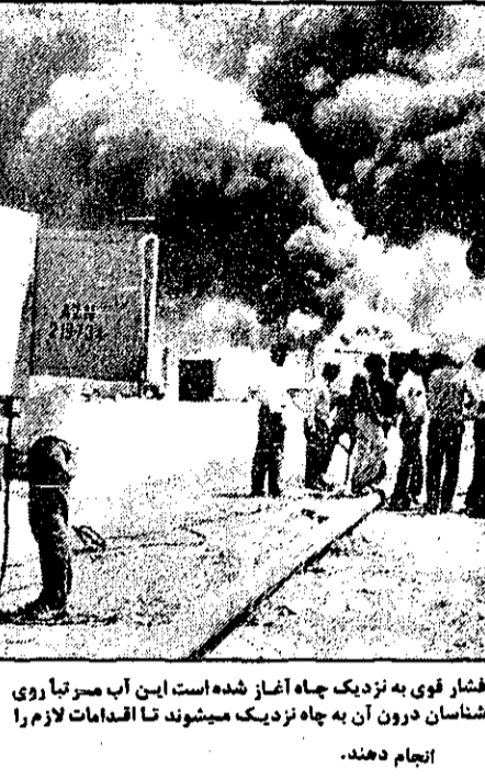
کشیدن یک خط لوله آب با فشار قوی به نزدیک چاه آغاز شده است این آب مرتباً روی اتاقکی ریخته میشود که کارشناسان درون آن به چاه نزدیک میشوند تا اقدامات لازم را انجام دهند.
