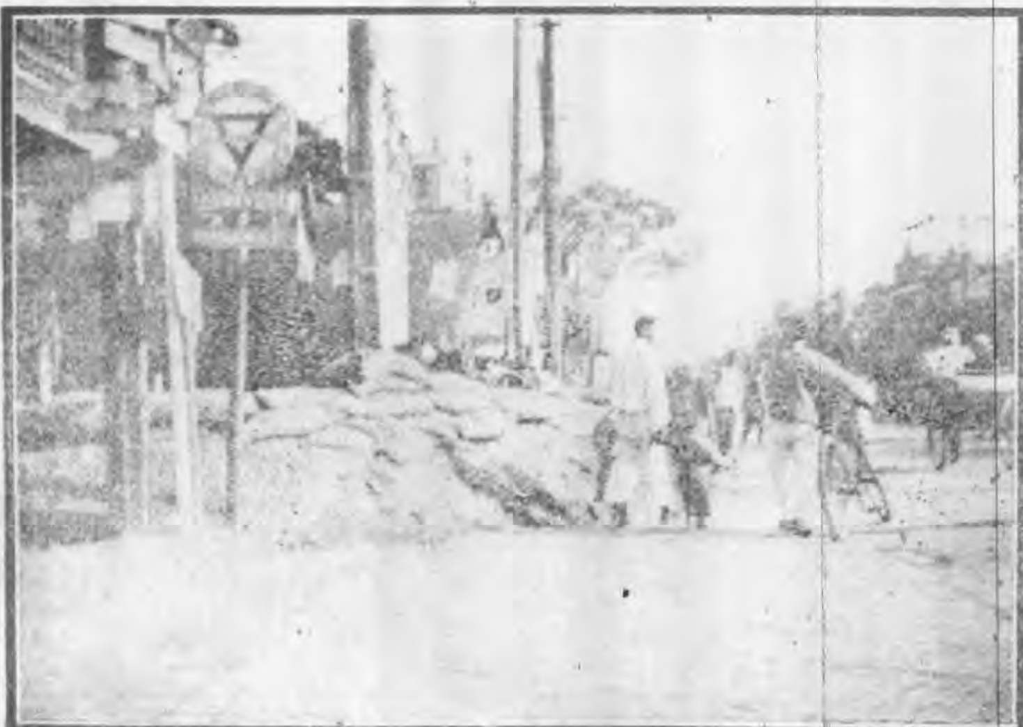
(社 北 東)。禦沙袋土置設樓牌單西平北：下
