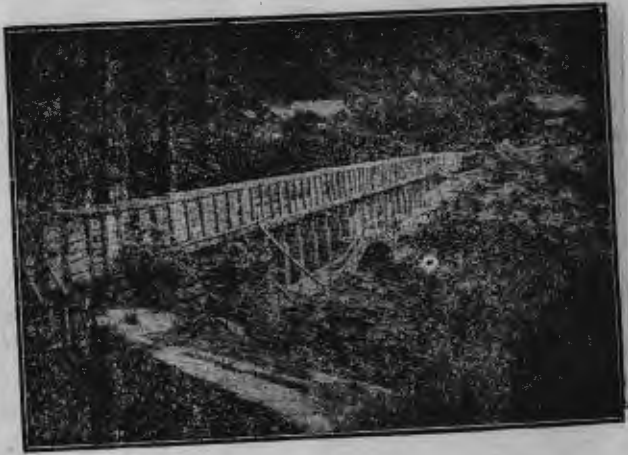
圖 4 高家大溝渡槽之一
