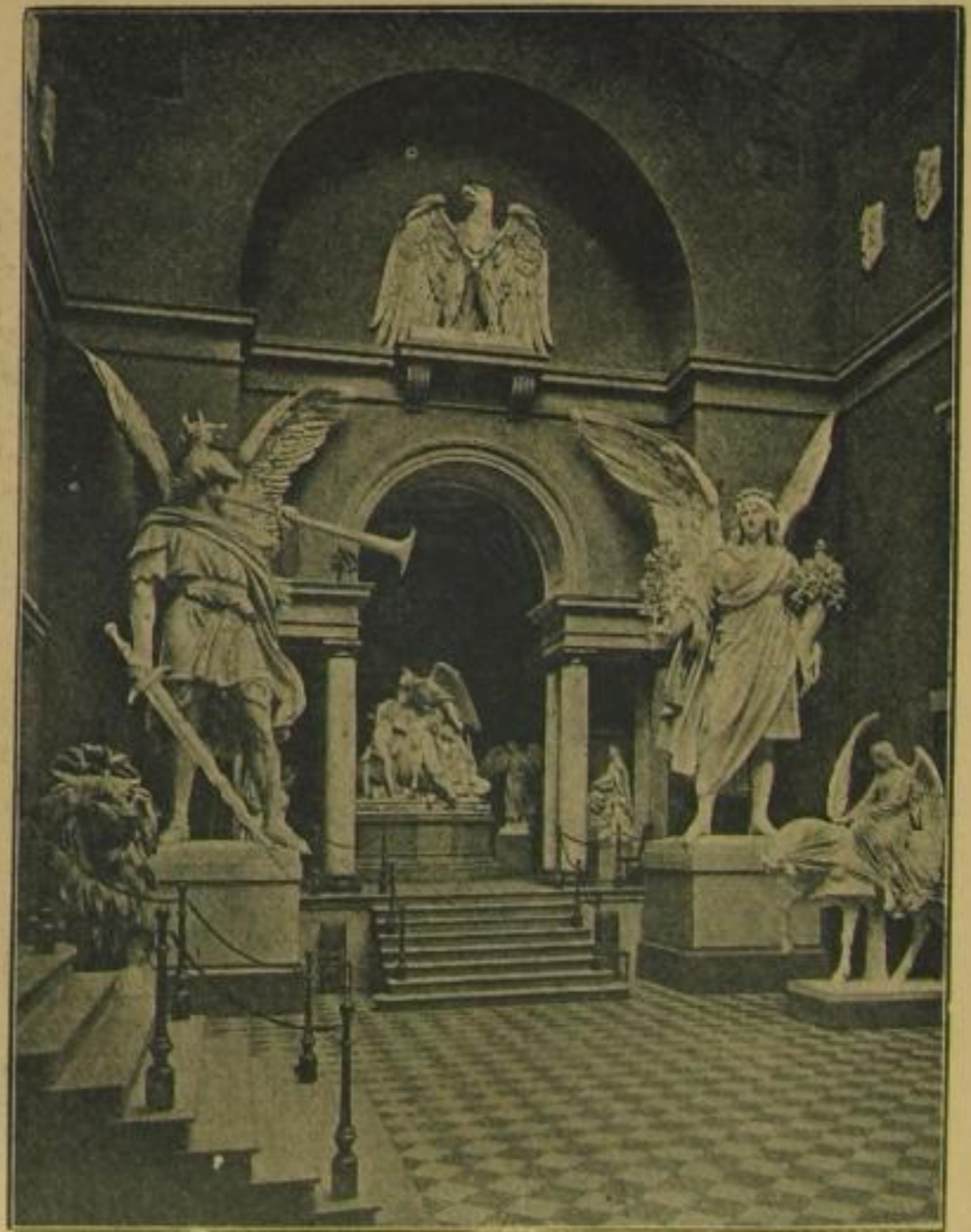
Krieg, Blick nach der Halle, Friede. Krieg, Blick nach der Halle, Friede.
