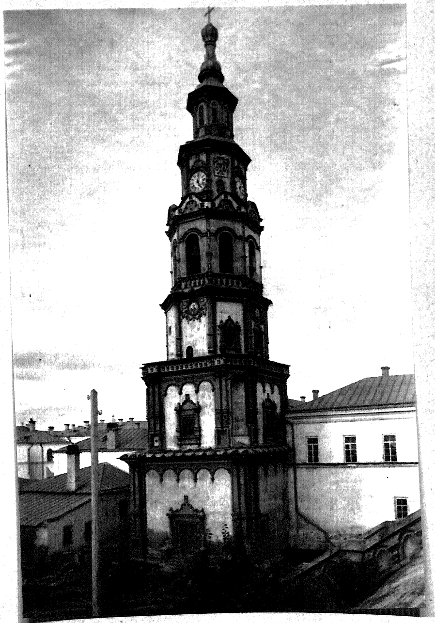
Казань. Колокольня Петропавловской церкви. 1720-е годы.
