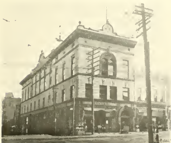
I. O. O. F. BUILDING, BUTLER
