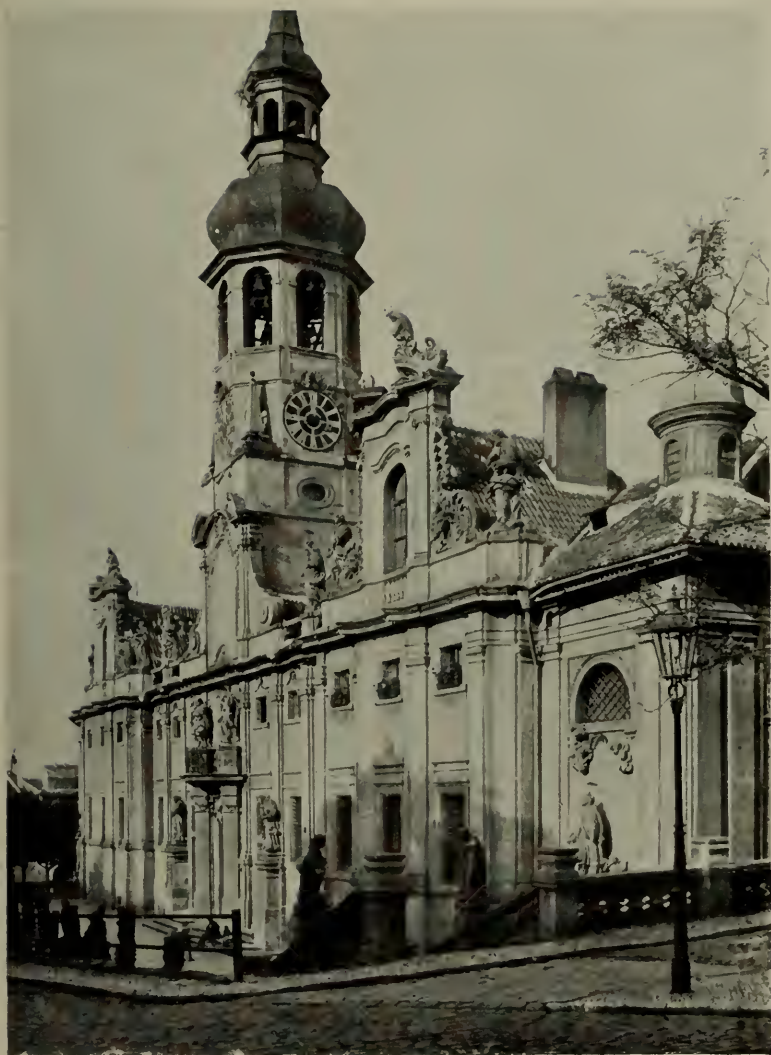
PRŮČELÍ CHRÁMU V LORETTĚ.
