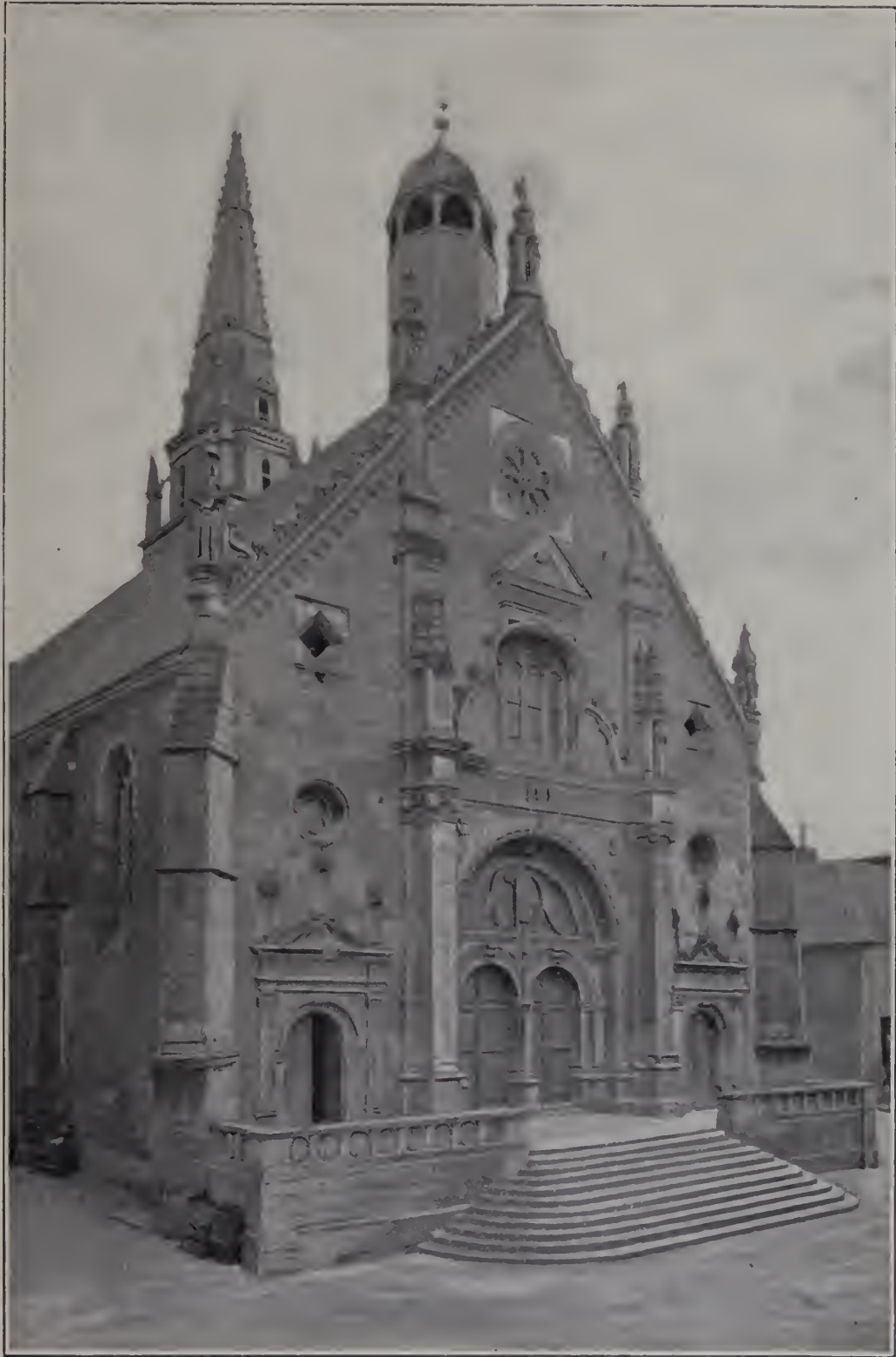
EGLISE DE SAINT-CALAIS, DANS LE MAINE École des maîtres maçons de la Ferté-Bernard
