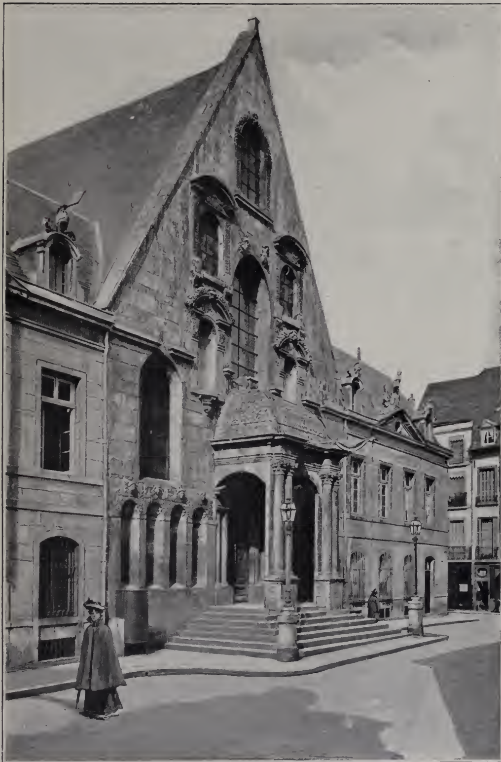
FAÇADE DU PALAIS DE JUSTICE, A DIJON Œuvre d'Hugues Brouhée
