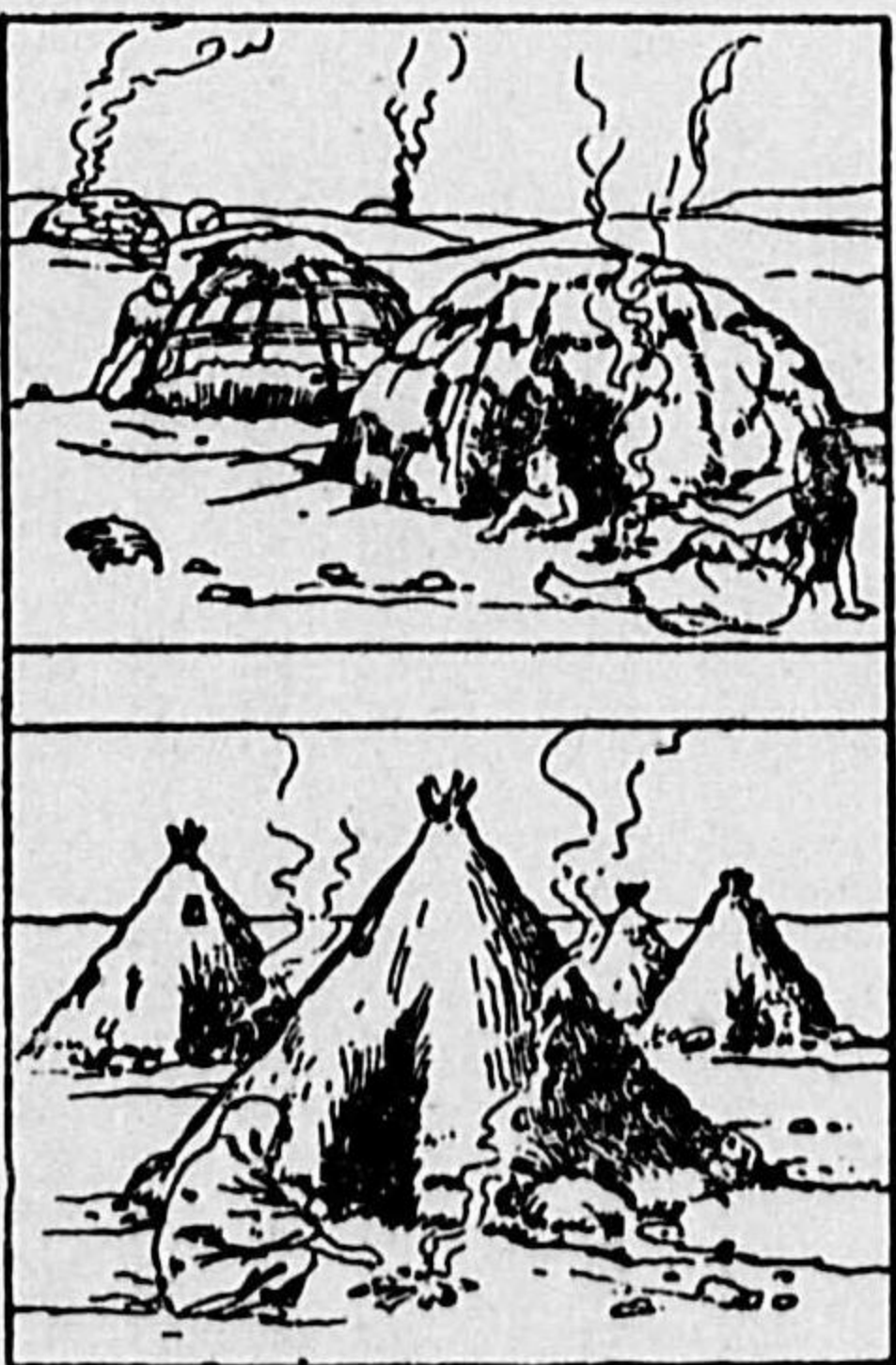
其中心柱に寄掛けられた若木や樹枝が垂木を形作り、そして其の垂木の方向と直角をな
