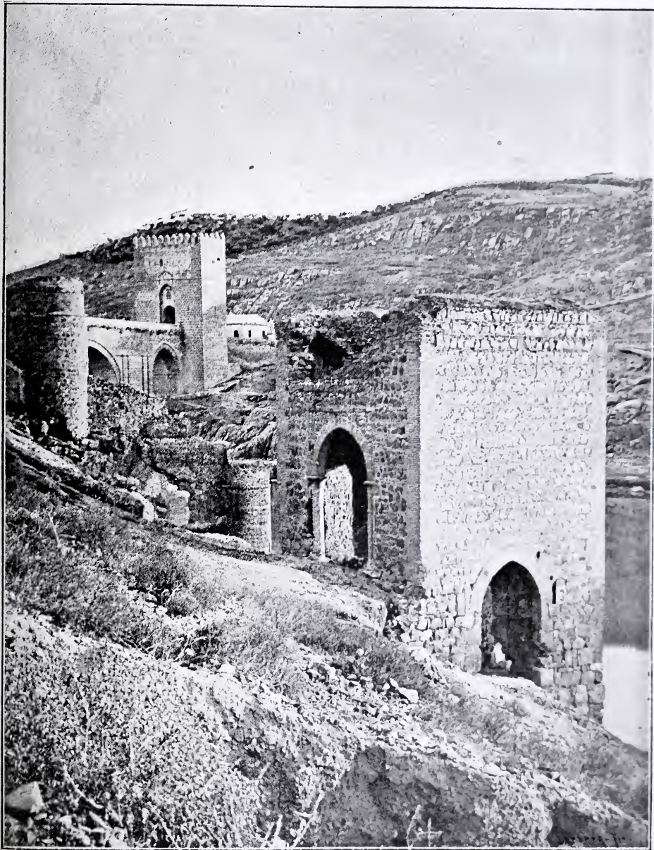
TORREÓN DEL PUENTE DE BARCAS EN TOLEDO, LLAMADO Baño de la Cara , Y PUENTE DE SAN MARTÍN
