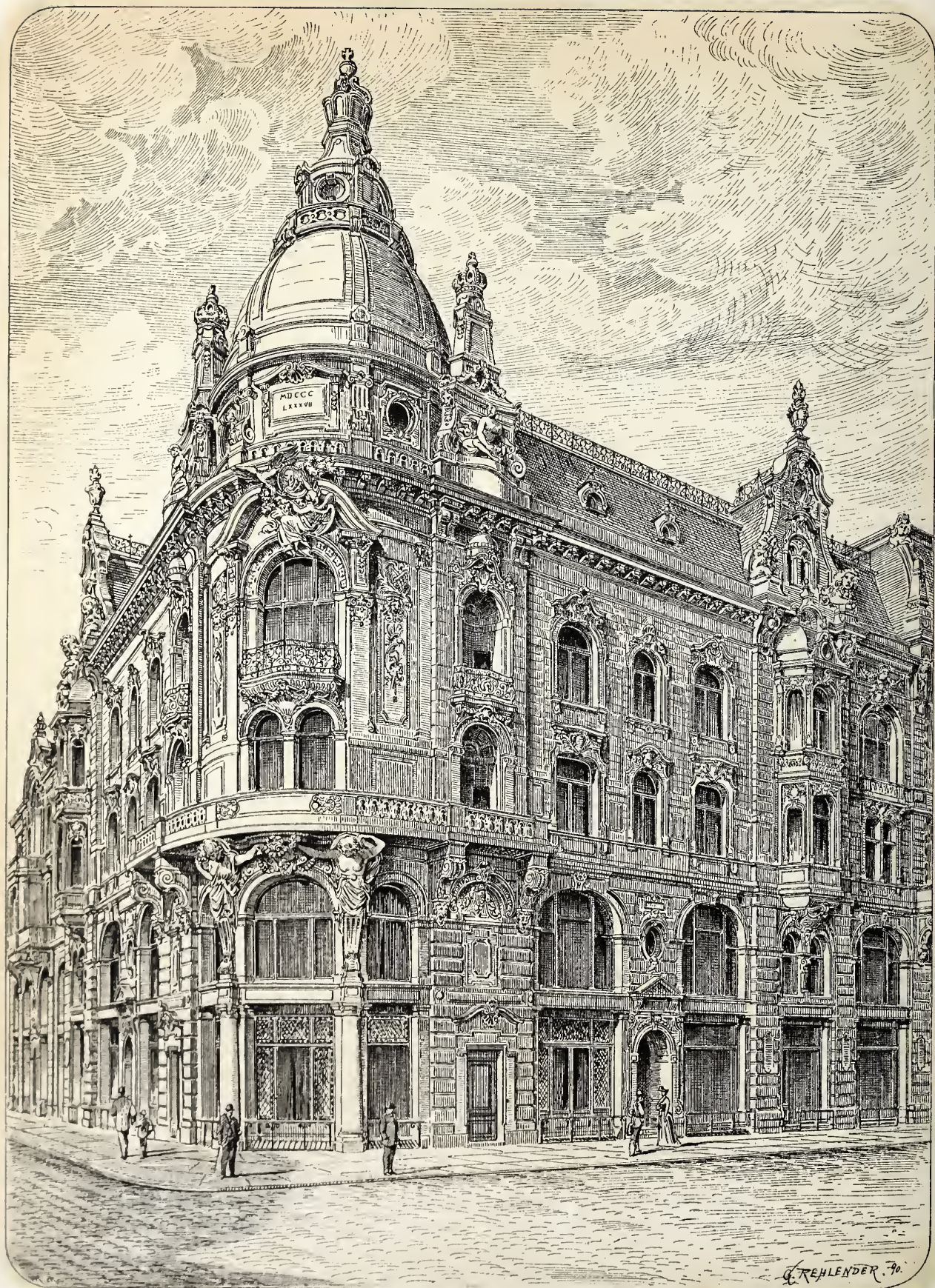
Eckhaus der Kaiser-Wilhelmstrasse in Berlin, erbaut von CREMER und WOLFFENSTEIN.
