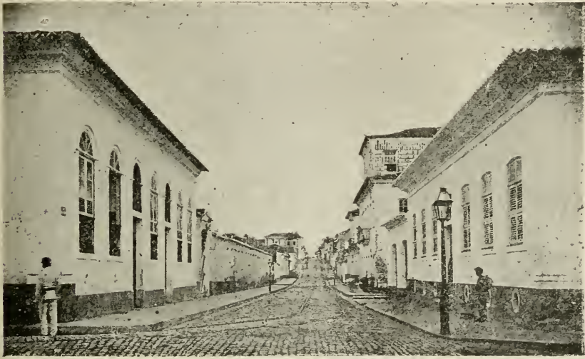
S. Luiz. — Part of the « rua dos Remedios »
