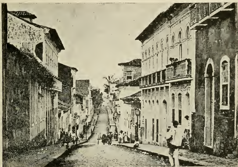
S. Luiz. — View of a Part of the « rua do Sol »
