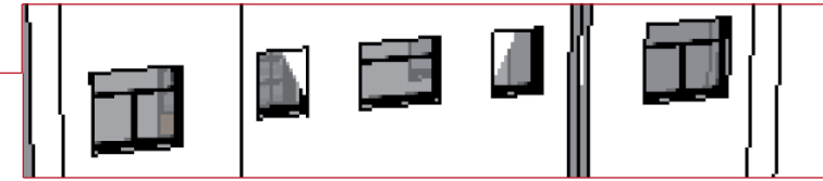
Vanos dispuestos simetricamente en la fachada, controlan la luz en el interior de la vivienda.
