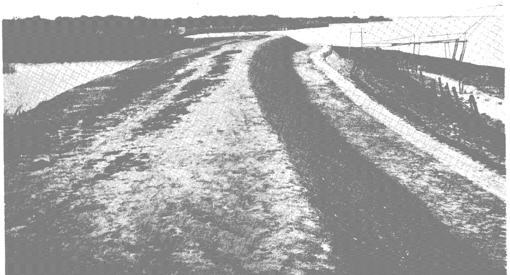
椿石工程與土塘完竣後情形
