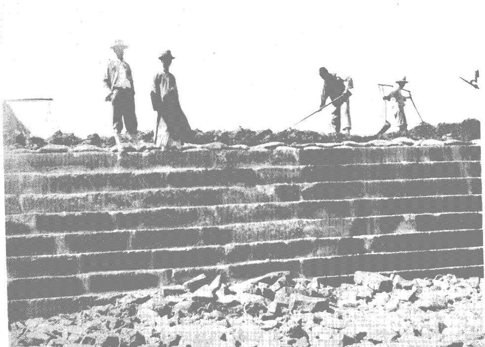
→ 吳淞區木峯石塘搶修完成
