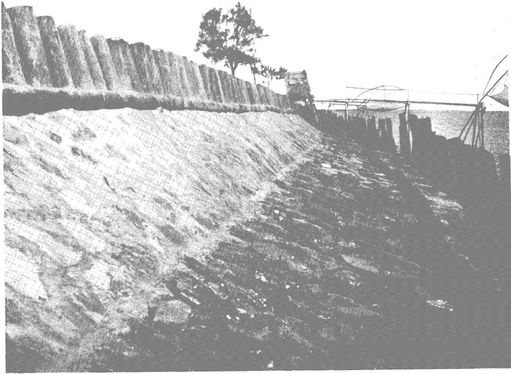
二十一年東塘椿石工程膠砌石坦坡及乾砌石坦坡完工後之情形
