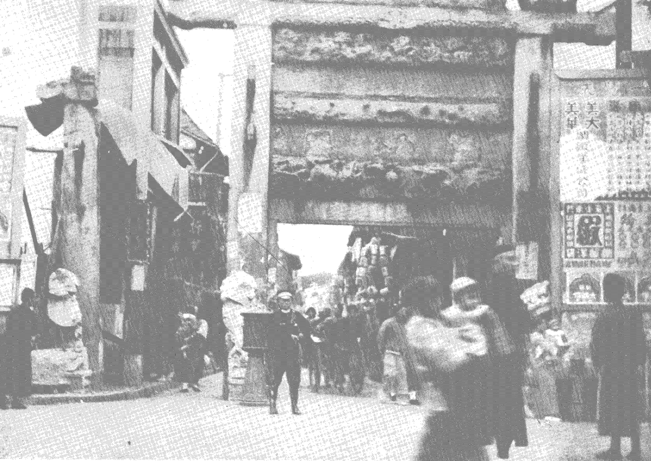
縣基路口之閣老坊，爲明徐文定公之紀念坊，以年久失修，且曾經火毀，危險異常，不得已加以拆除。拆下石料之尙成片段者，概送徐家滙文定公寢保存，並將牌坊所在地之縣基路改稱光啓路，以紀念之。下爲光啓路近狀。
