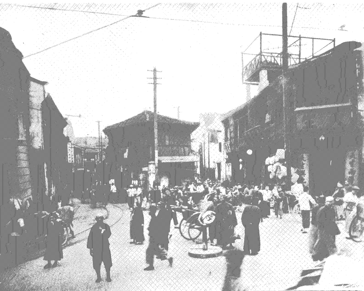
滬南區集水街與方浜路未整理前之狀
