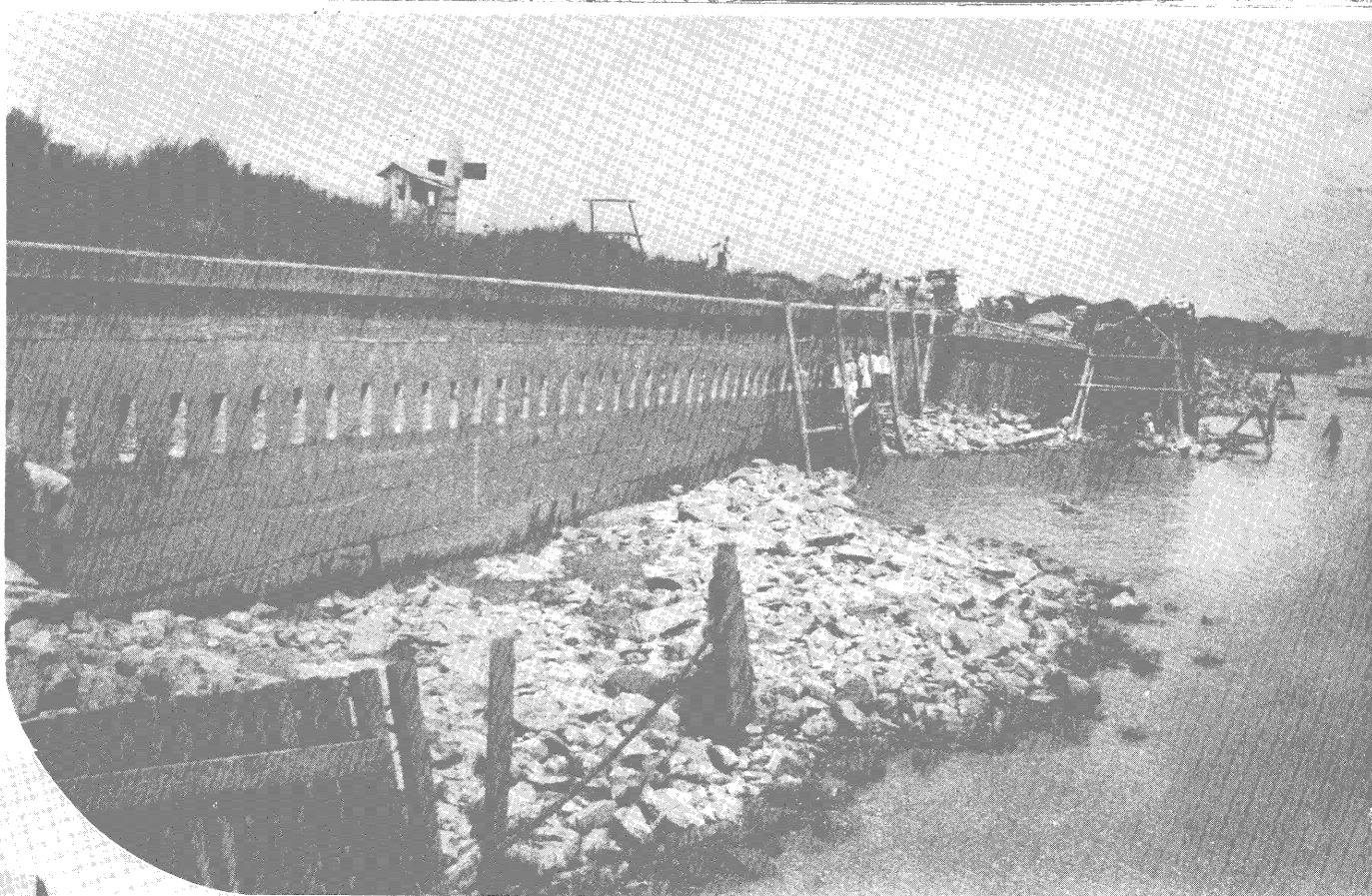
(上)東塘區澗設修理鋼筋混凝土塘施工情形
