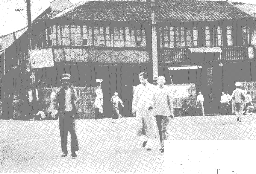
和平路動工開始拆屋
