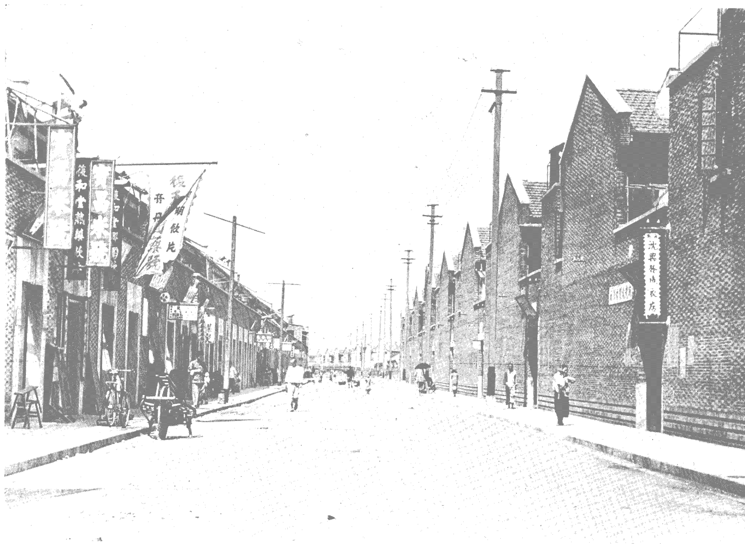
◆ 寶昌路冷柏油路面完成
