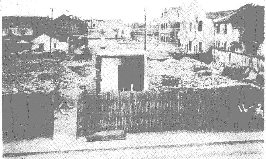
舊屋在拆除中
