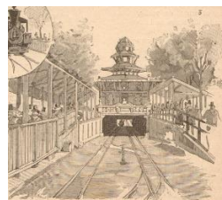
Underpass at Eiffel Tower (Pont d'Iéna)
