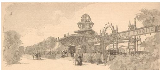
Station de la Concorde (Esplanade des Invalides)
