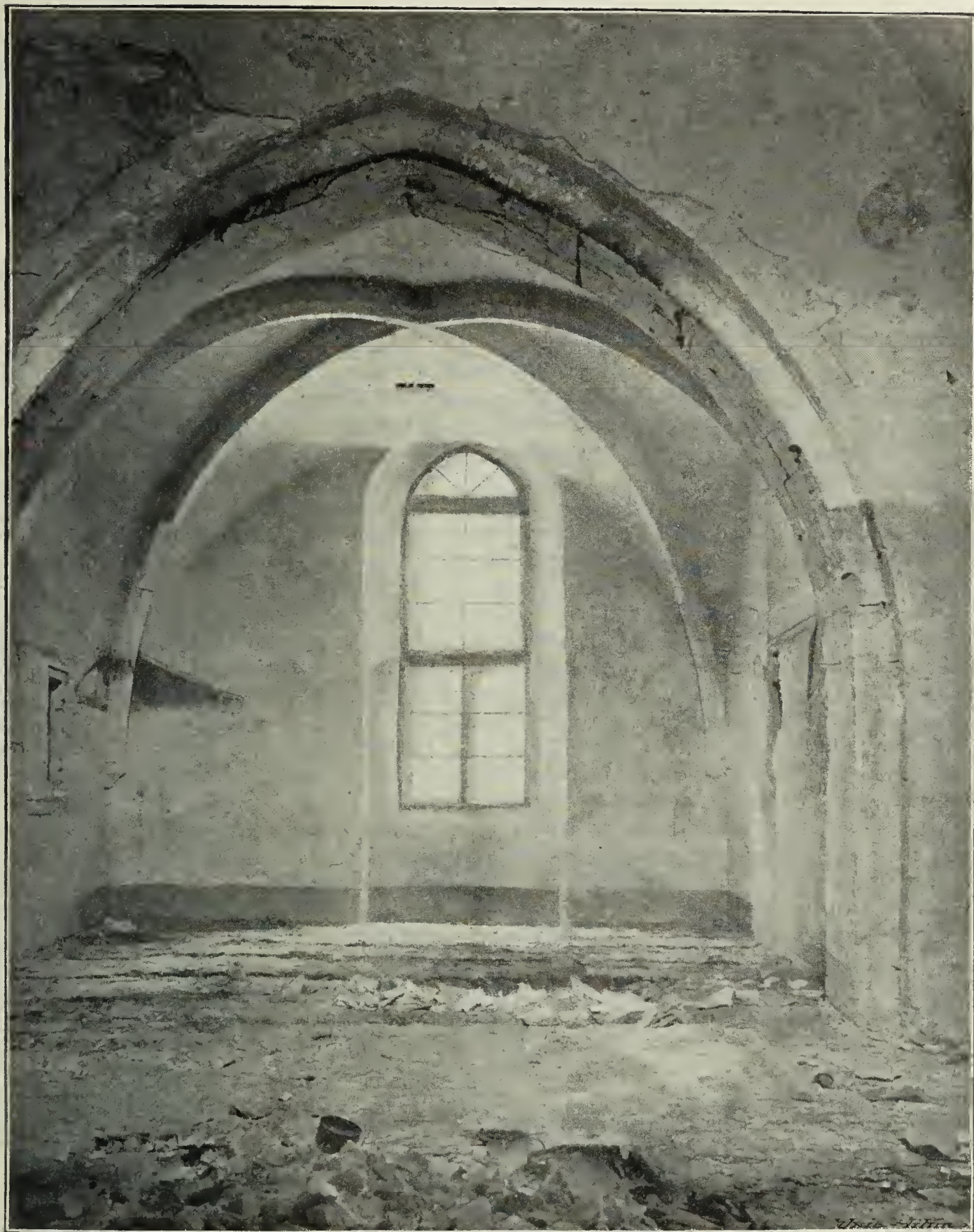
Obr. 6. Pohled od vchodu z hlavní lodi do presbytáře.
