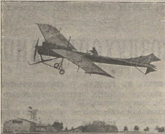
Полетъ Латама на новомъ монопланѣ „Антуанетъ“ съ 16-цилиндровымъ моторомъ „Антуанетъ“ въ 100 л. с.
