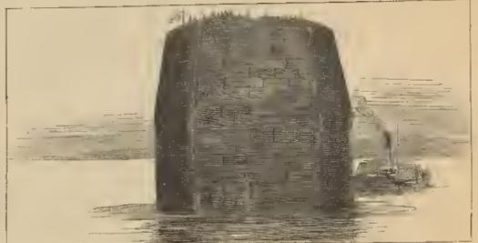
Figura 3. - Remolque de un cajón
