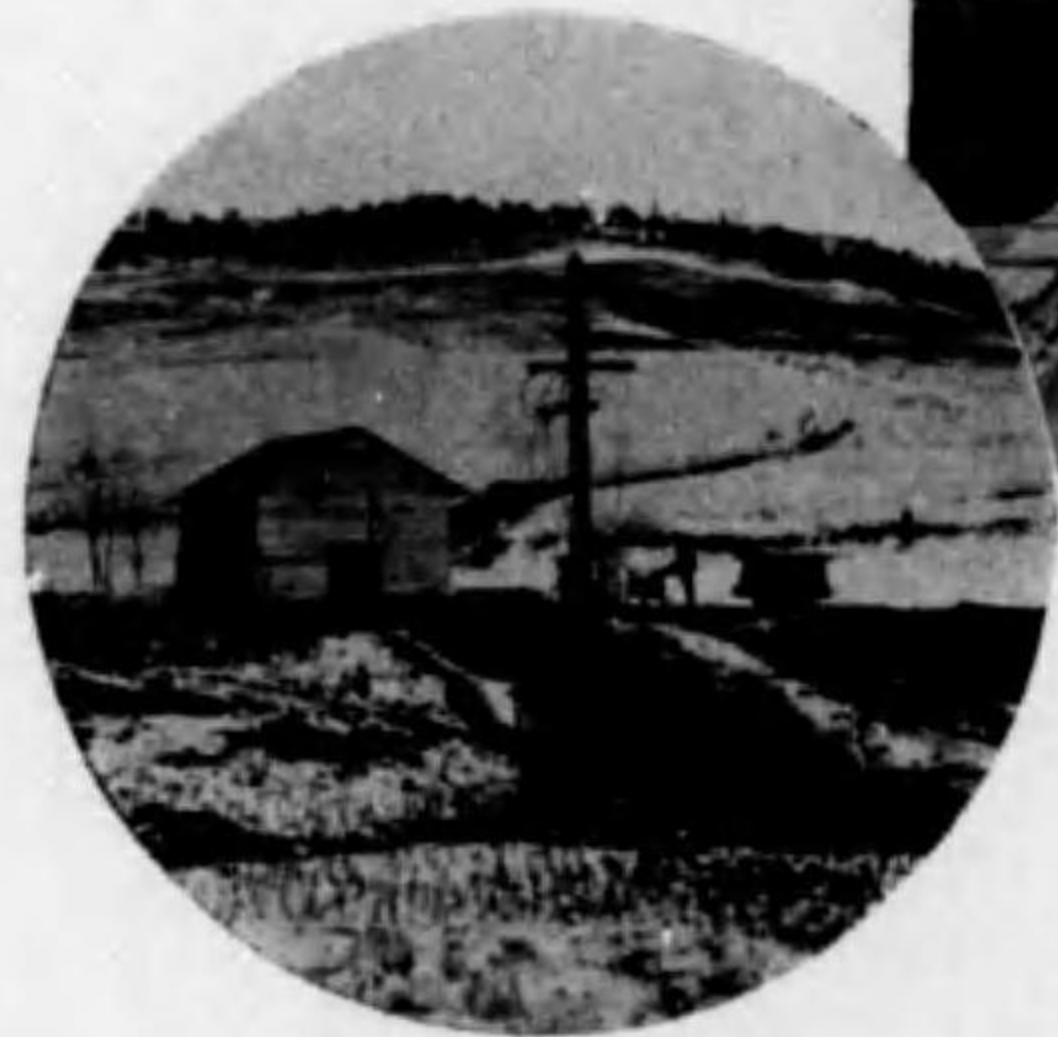
開坑直後の坑口
