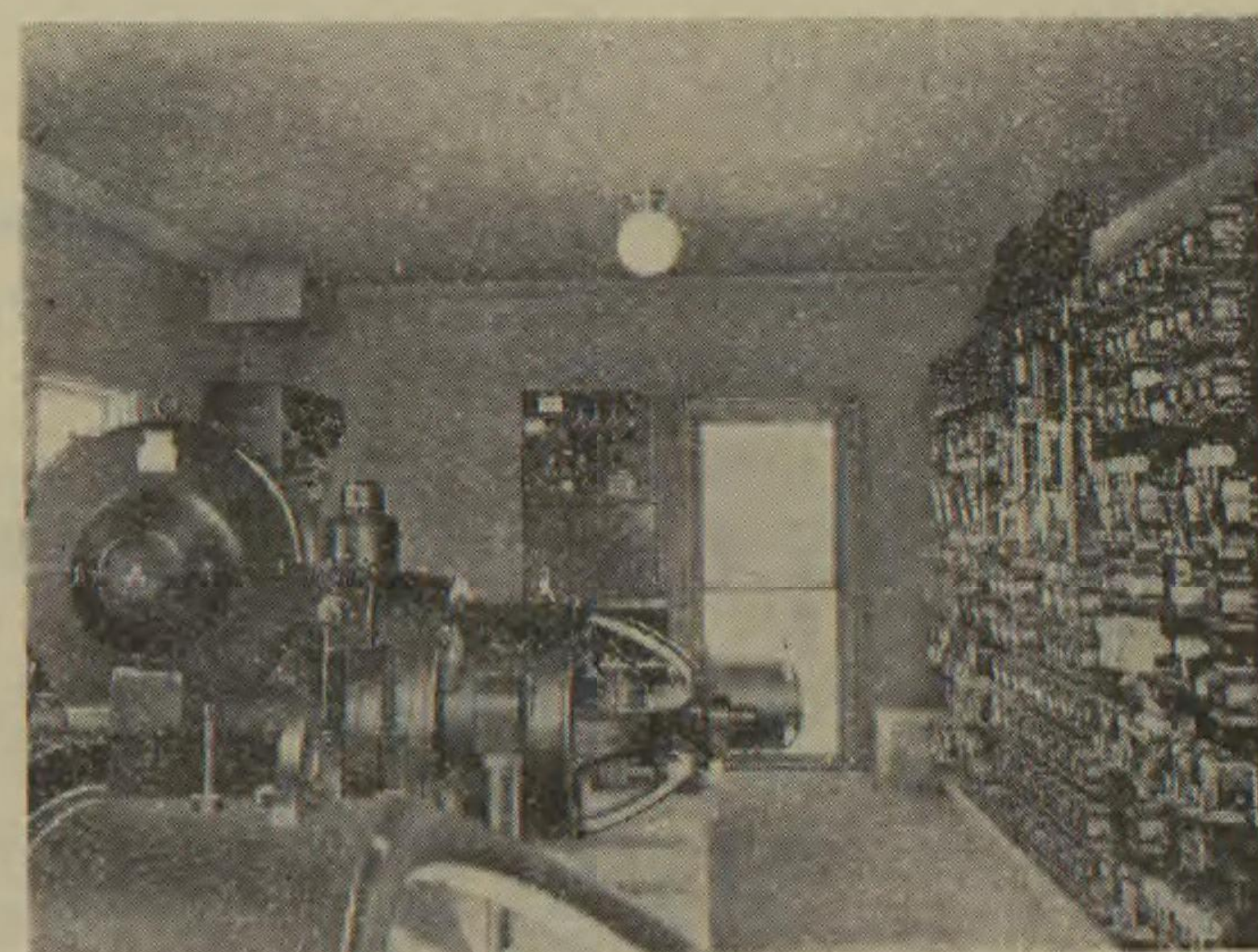
第6圖 可變電壓 齒車式 エレベータ
