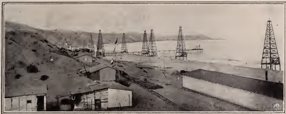
Fig. N° 5.—Establecimiento Industrial de Zorritos.—Vista general de la caleta de Zorritos, con la serie de pozos perforados en la orilla y dentro del mar.
