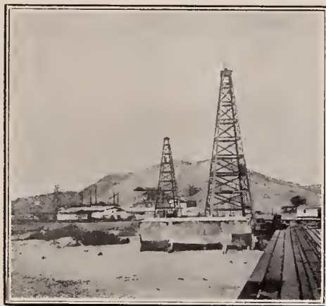
Fig. N° 6.—Establecimiento Industrial de Zorritos.—Vista de conjunto de la Refinería.
