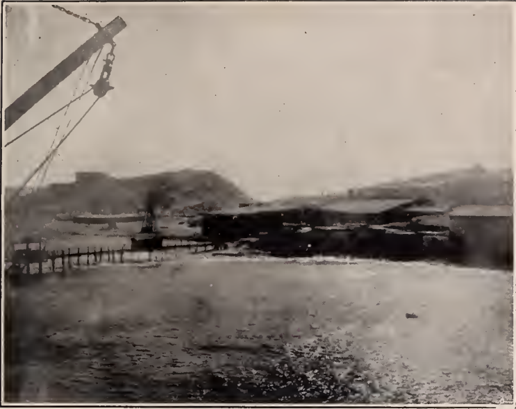
Fig. N° 7.—Vista del puerto de Talara, de propiedad de "The London and Pacific Petroleum C°."
