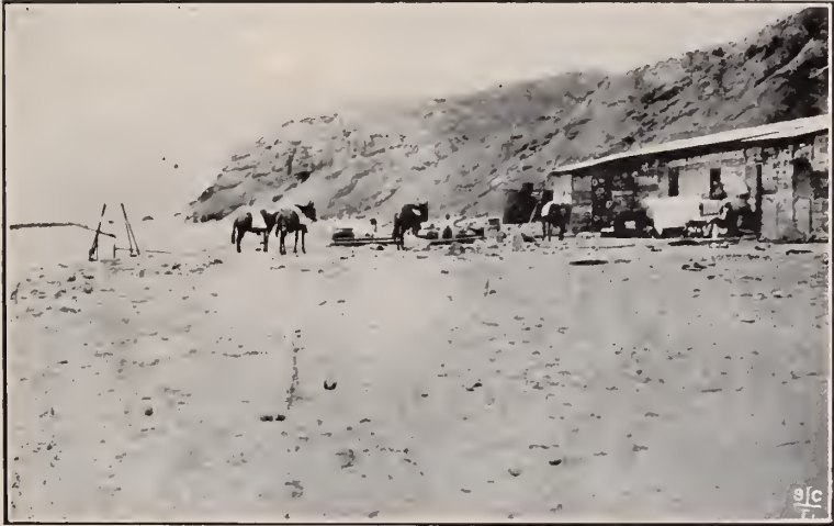
Fig. N° 14.—Zona de Cabo Blanco. Vista del puerto de Cabo Blanco, con los restos de la antigua Compañía Nacional.
