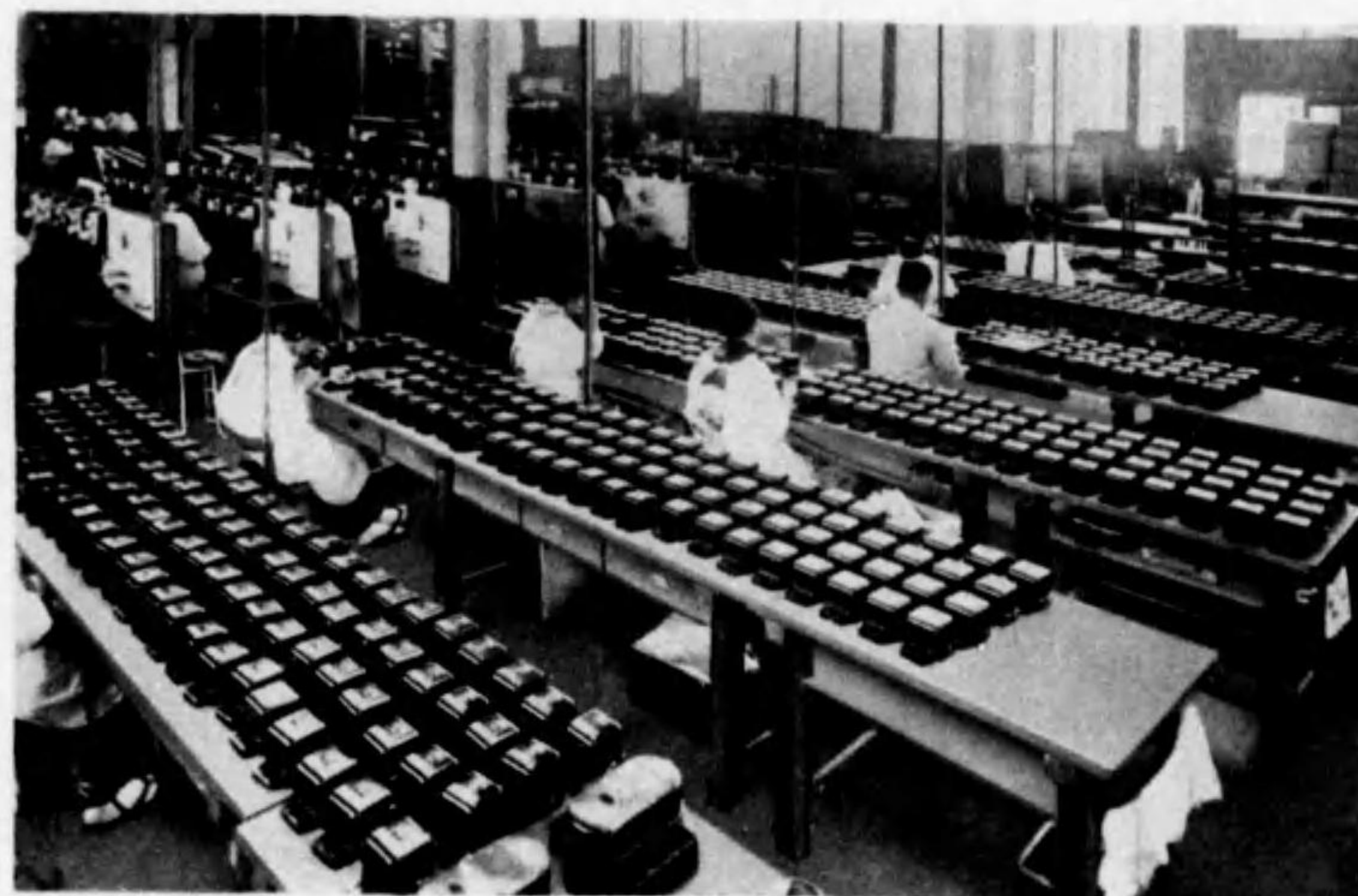
往時の積算電力計工場の一部
