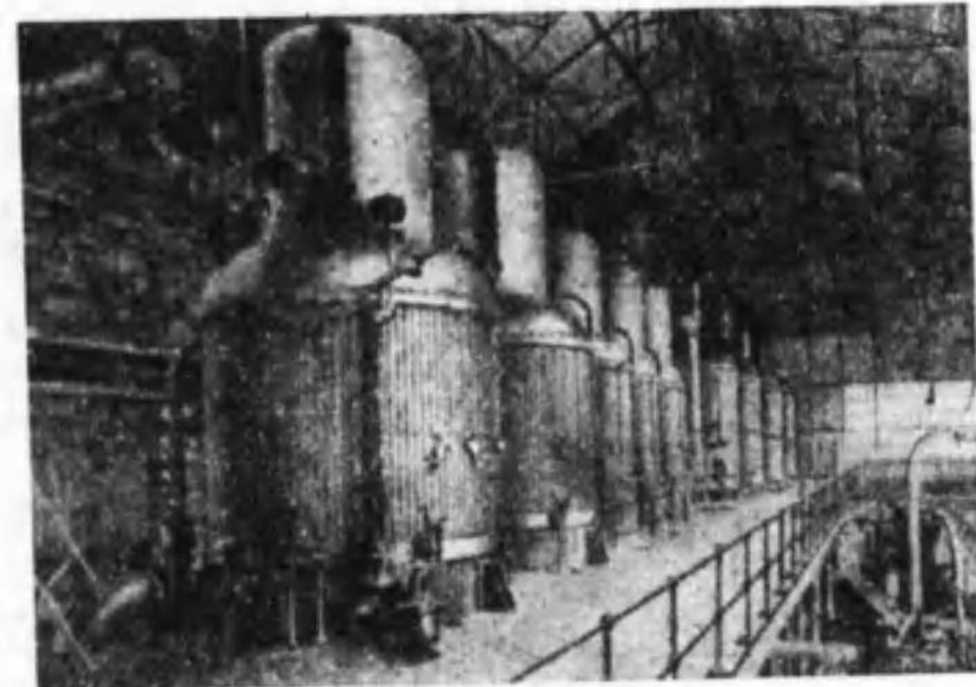
圖 31 の 12 四重効用罐
