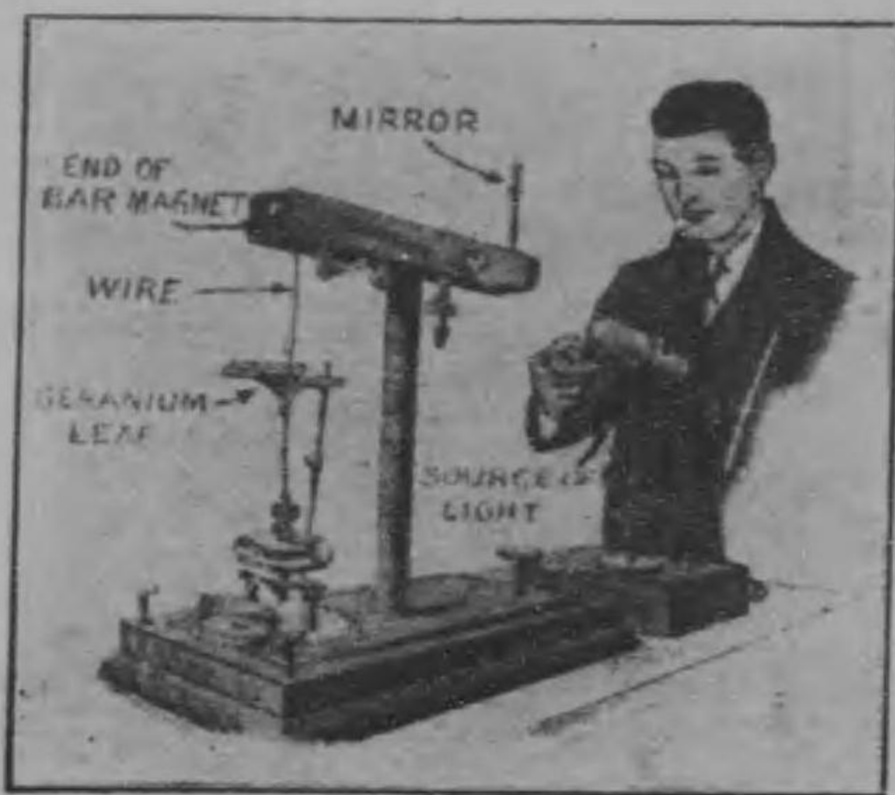
廓大鏡の構造 Mirror 鏡、End of B.M. 磁力棒の端、Wire 導線、Geranium Leaf げんのしやうこ屬の葉、Source of Light 光源
