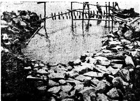
▲ 意溪鄞江館第一號石碼施工情形
