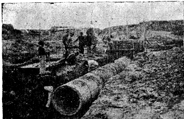
單管涵洞管身接駁情形
