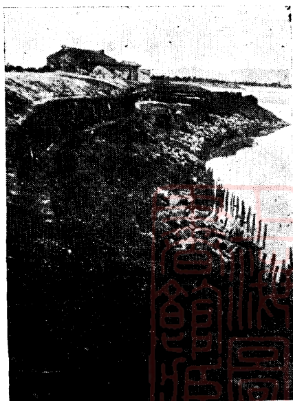
東廂竹蟻段實施工程情形
