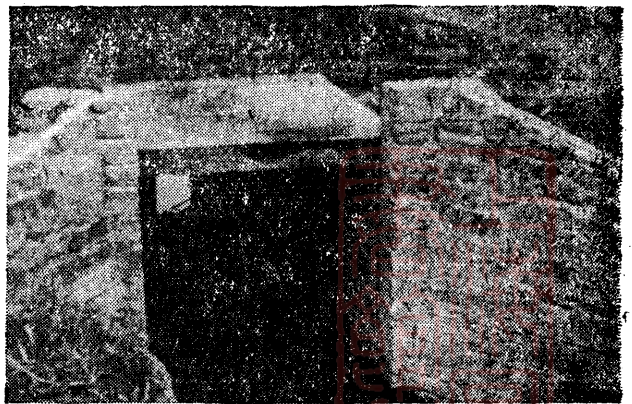
已 完 成 之 浦 尾 涵 洞 翼 牆 及 涵 面
