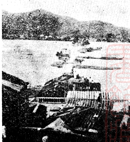
第三次洪水漫過洲子橋於低級橋面上
