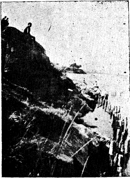
→江東圍洋澗沼下段堤未修理前之險象
