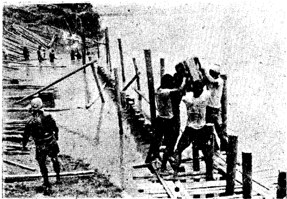
聯安圍打樁情形
