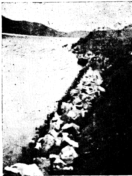
▲江東洲第二段施工情形
