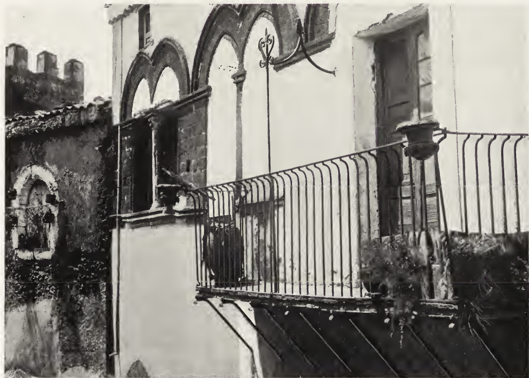
RANDAZZO — FINESTRE DI CASA LA MACCHIA.
