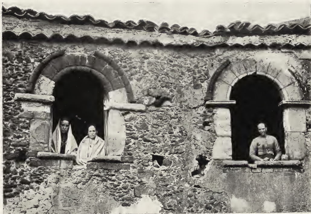
RANDAZZO — FINESTRE DI VIA GRANATARA.
