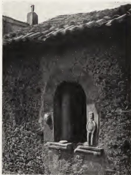
RANDAZZO — FINESTRA DI CASA CALDERARA.
