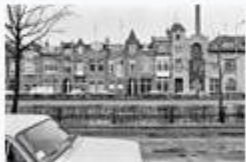
Overzicht voorgevels - 's- Hertogenbosch - 20110253 - RCE.jpg 1.200 × 788; 257 kB
