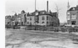
Overzicht voorgevels - 's- Hertogenbosch - 20110252 - RCE.jpg 1.200 × 788; 228 kB
