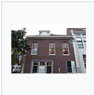
Guldenvliesstraat 2, Den Bosch, gevelaanzicht boven.jpg 4.896 × 3.264; 6,38 MB
