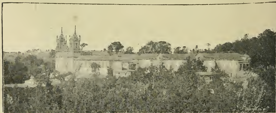
Fachada do convento da Costa
