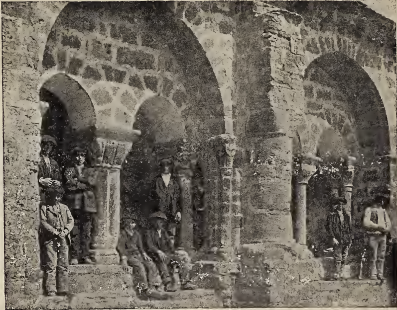
Pórtico de Gazolaz (Navarra).
