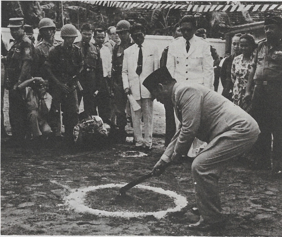
Presiden Sukarno mengayunkan cangkul sebagai tanda dimulainya Pembangunan Nasional Semesta Berencana di Jalan Proklamasi pada tanggal 1 Januari 1961.
