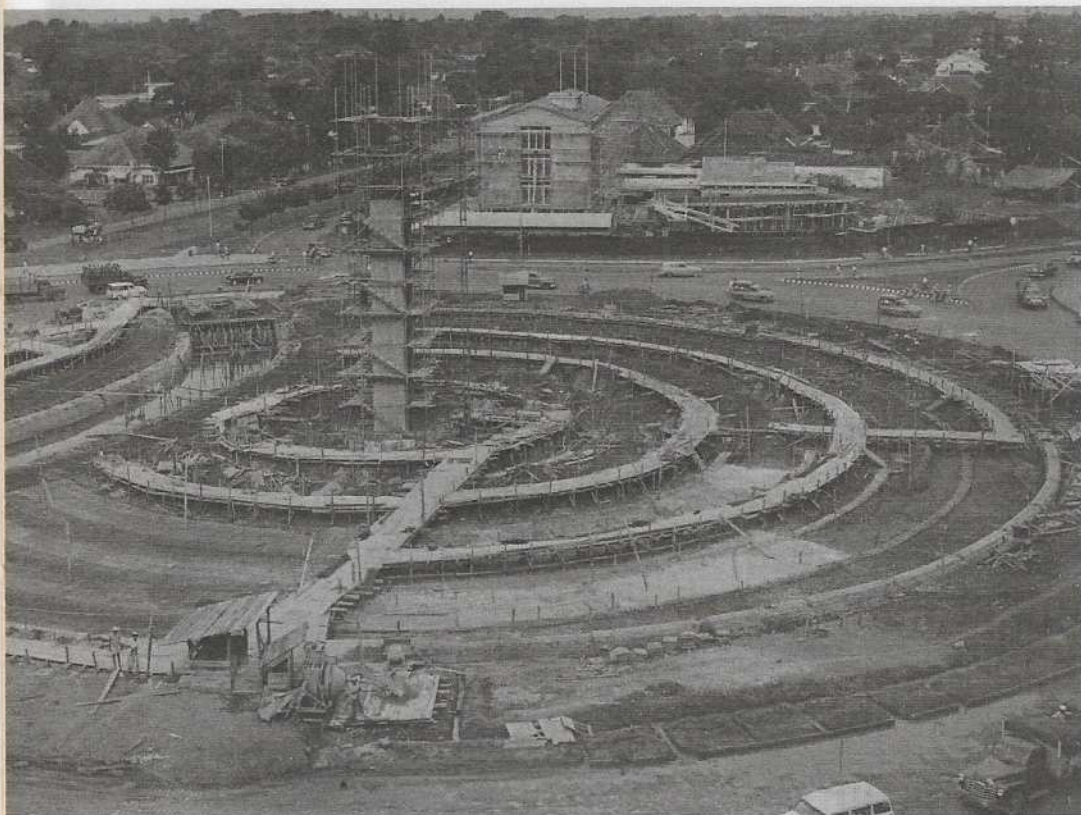
Pembangunan Tugu Selamat datang di Bunderan Hotel Indonesia.
