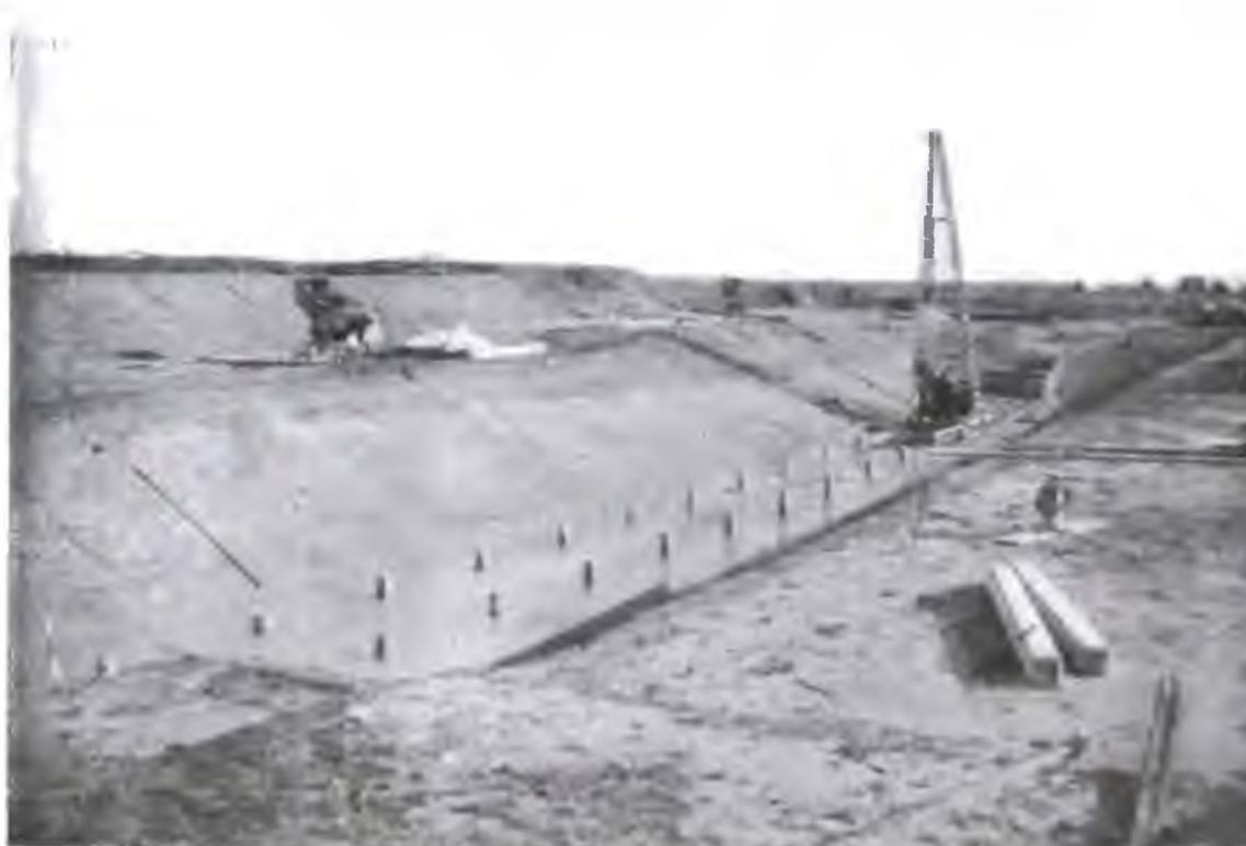
**Sifón Hm. 113,72 del Canal Nº 5. — Pilotaje de fundación.**
