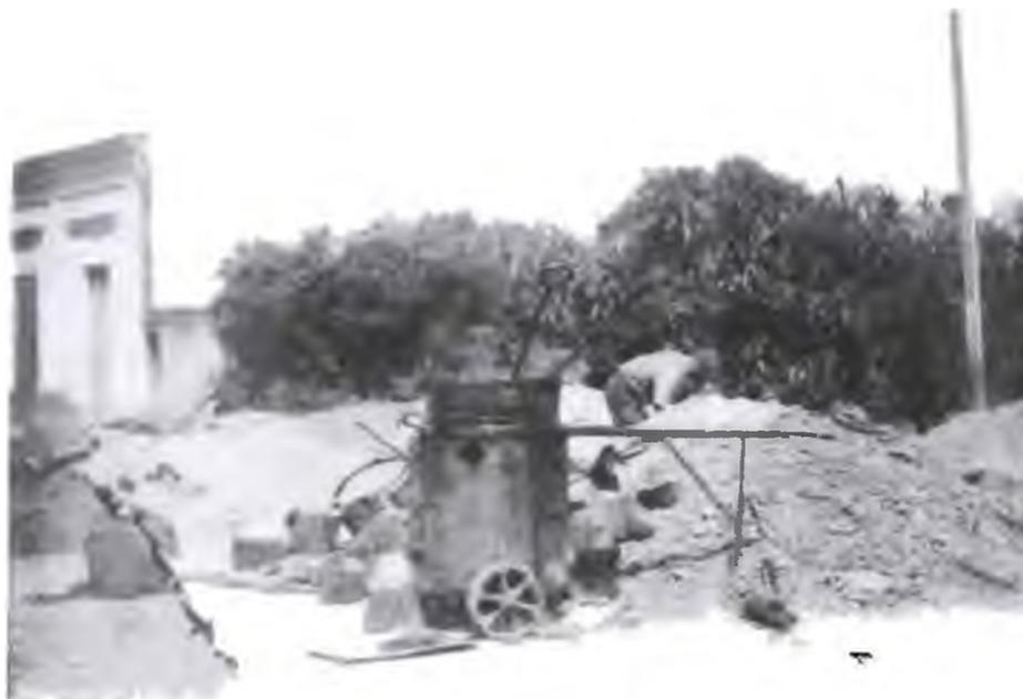
Equipo de braseiro completo para derretir mastic asfáltico para las juntas de la cañería de material vítreo.
