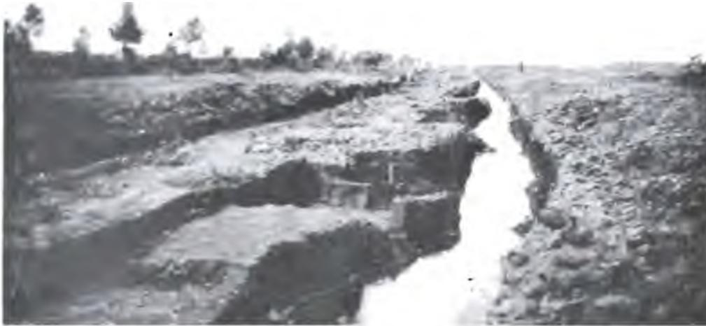
Limpieza del cauce del río Salado, zanje preliminar para secar una cancha de desagüe.
