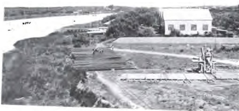
Darsena 3. Vista del hormigonado y estiba de tablestacas metálicas.
