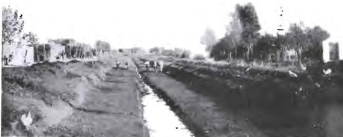
**Limpieza del arroyo Maldonado. — Vista del trozo anterior después de terminado el trabajo. Puntos de referencia, portón blanqueado y molino a a la derecha. Esta foto fué tomada desde la pasarela que figura en la anterior, sobre el Maldonado y Zanjón Sarmiento.**
