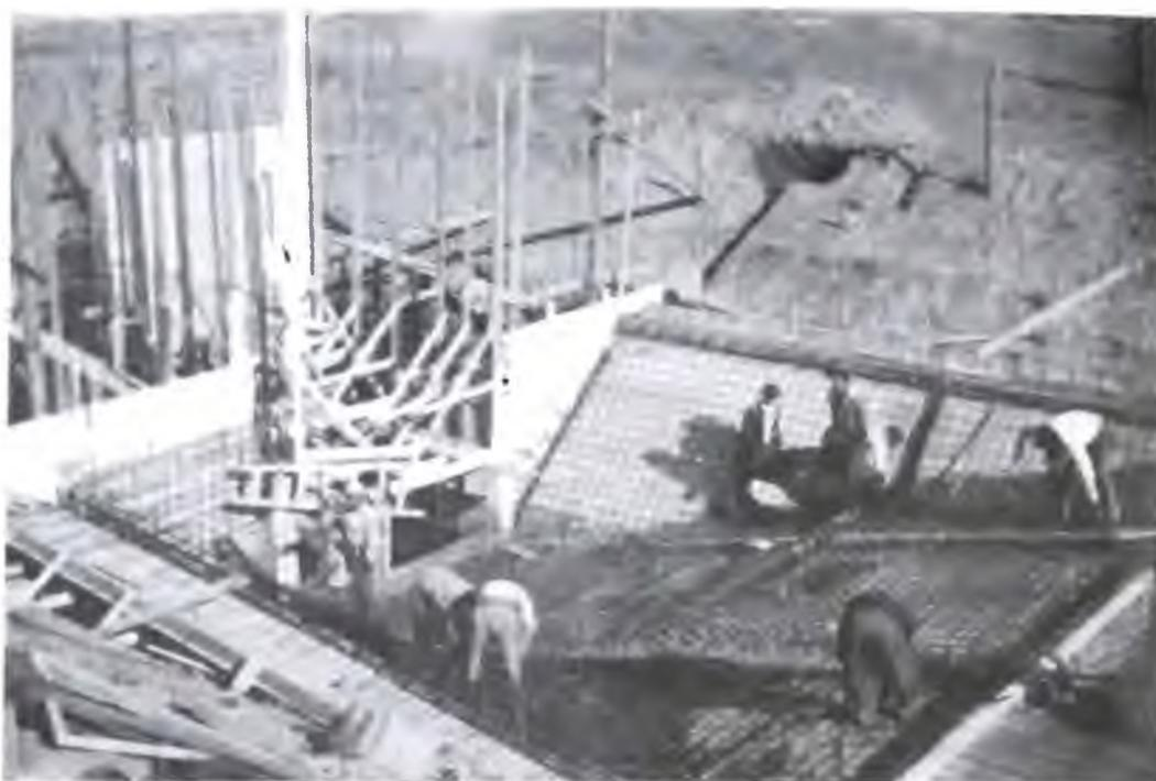
Sifón Hm. 113,72 del Canal N° 5.— Armaduras de la platea de la cabecera de descarga.
