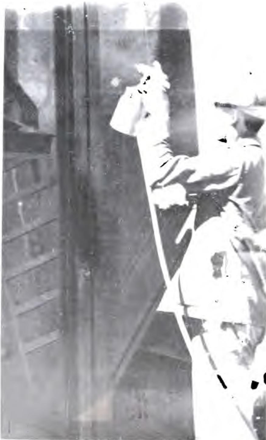
**Trabajos de pintura de compuertas mediante la utilización de aire comprimido.**
