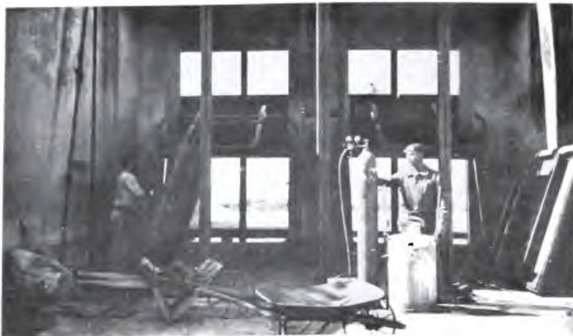
Canal N° 1. — Utilización de la soldadura autógena en los trabajos de reparación de compuertas.
