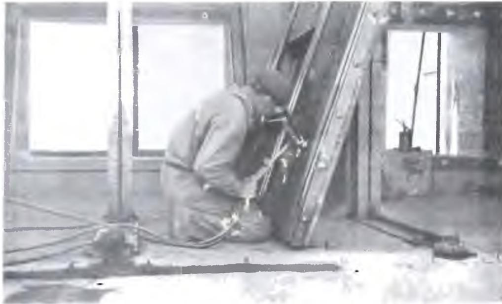
Canal N° 1. — Corte y soldadura de las hojas de compuerta mediante la utilización de la soldadura autógena.
