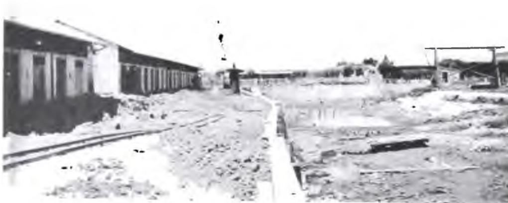
Dársena 2. — Vista del muro Este después del deslizamiento.
