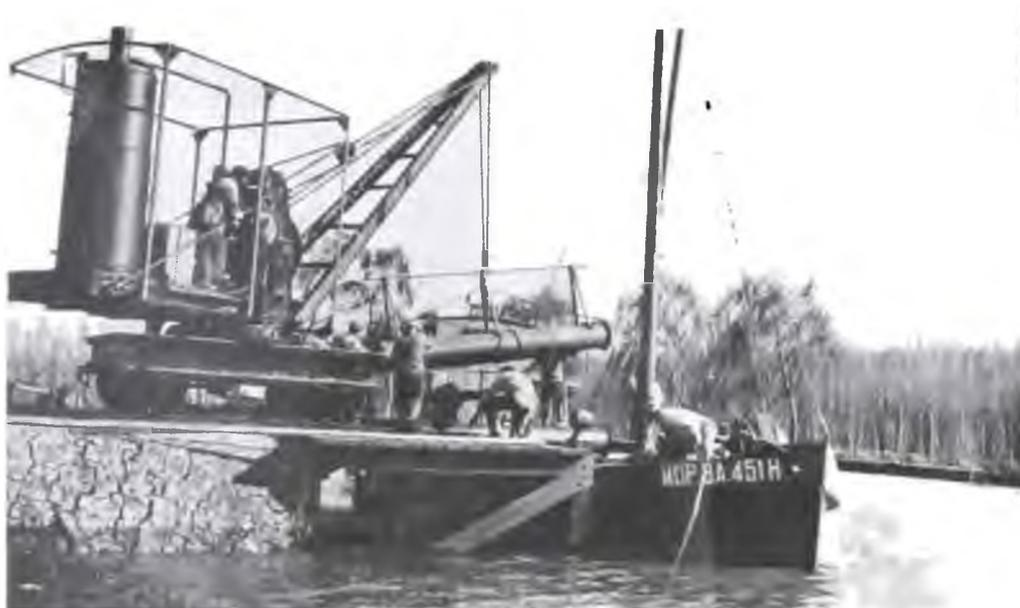
**Taller y varadero del Delta.— Esta vista muestra el Transporte 451 H. atracado en la Dársena principal, cargando cañería flotante con destino a las dragas que realizan trabajos de dragado en la zona.**
