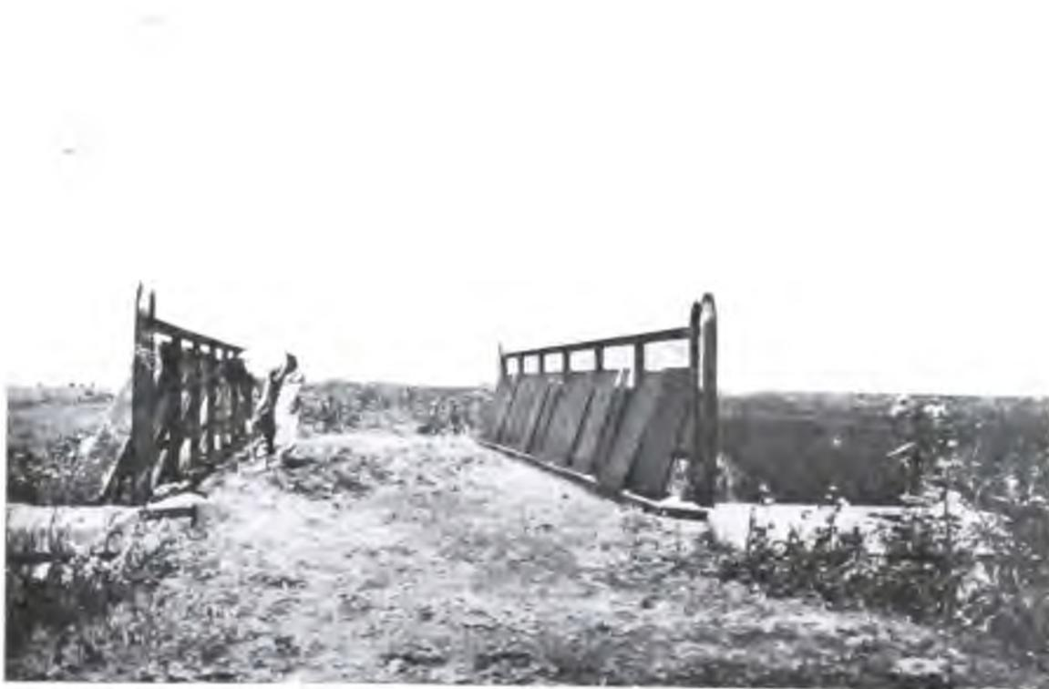
Canal N° 1. — Compuerta del canal durante los trabajos de reparación y pintura.
