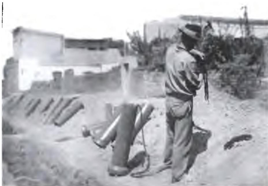
En las obras de ampliación de la red cloacal del Expediente V-69-1935, distribuyendo soga meollar en un caño de material vítreo de 0,152 m. de diámetro.
