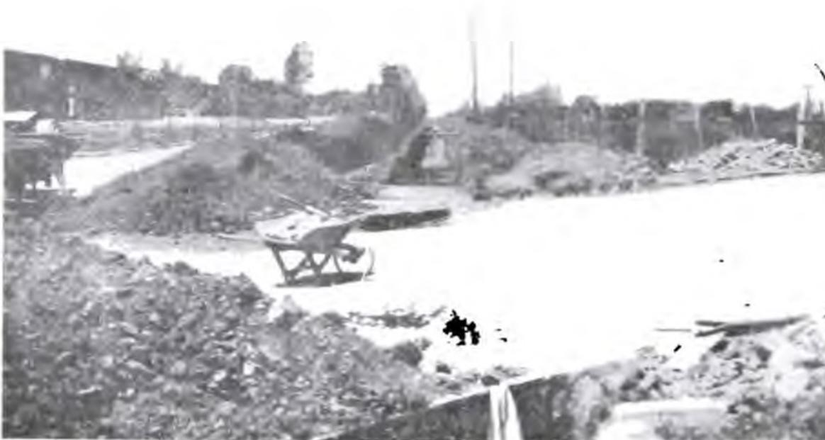
**Construcción del conducto de desagüe al costado del camino.**
