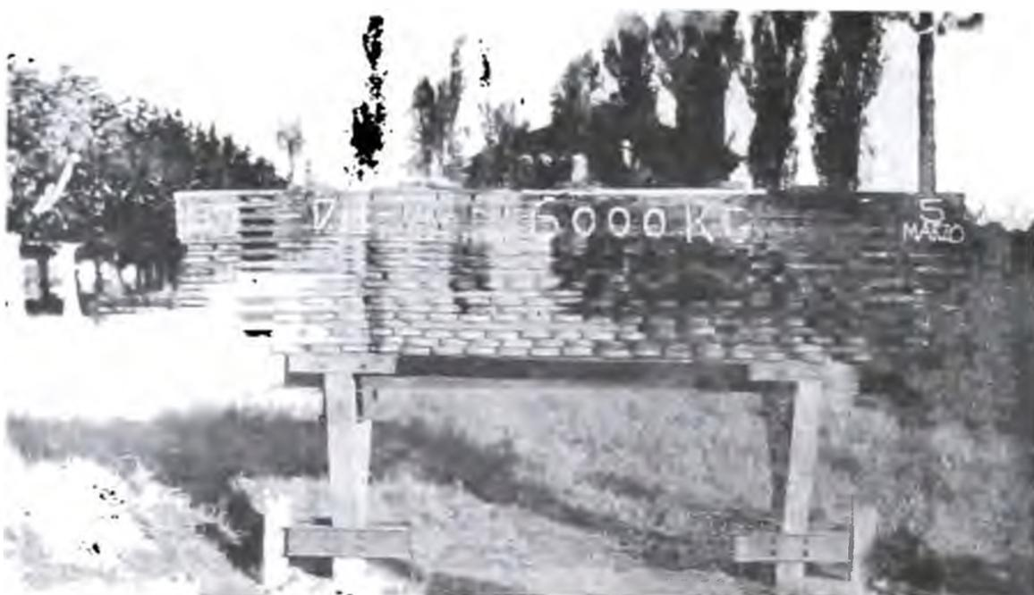
Taller y varadero del Delta. — Esta vista muestra un ensayo de resistencia del terreno (mayo 1937) para la construcción de un futuro edificio destinado a la Administración.
