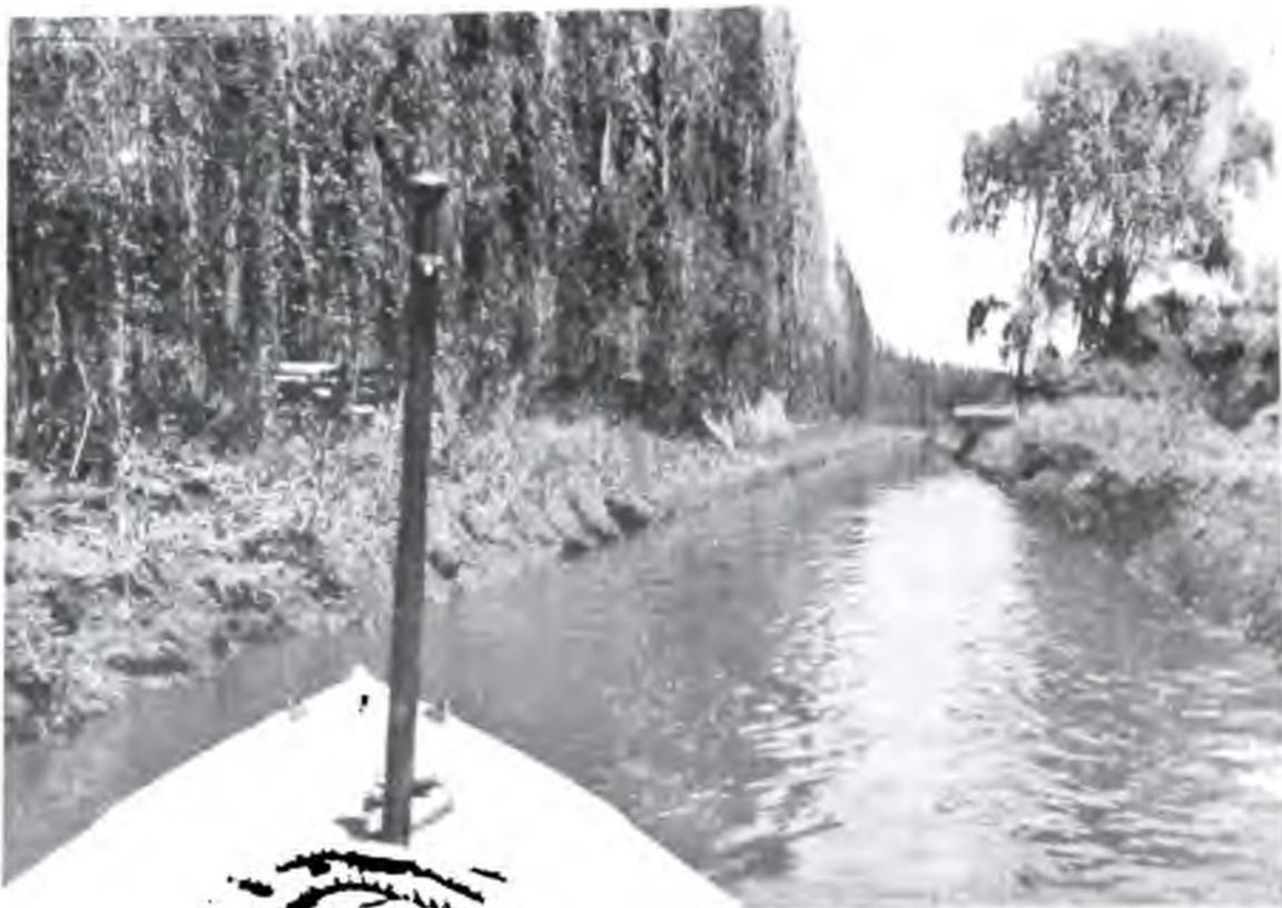
Arroyo Las Piedras (4.ª Sección). — Esta vista tomada en la acumulada 3000 m. muestra parte del arroyo después de haber pasado la cuadrilla con trabajos de limpieza de las costas, extracción de troncos del fondo del cauce y rectificación de las orillas.
