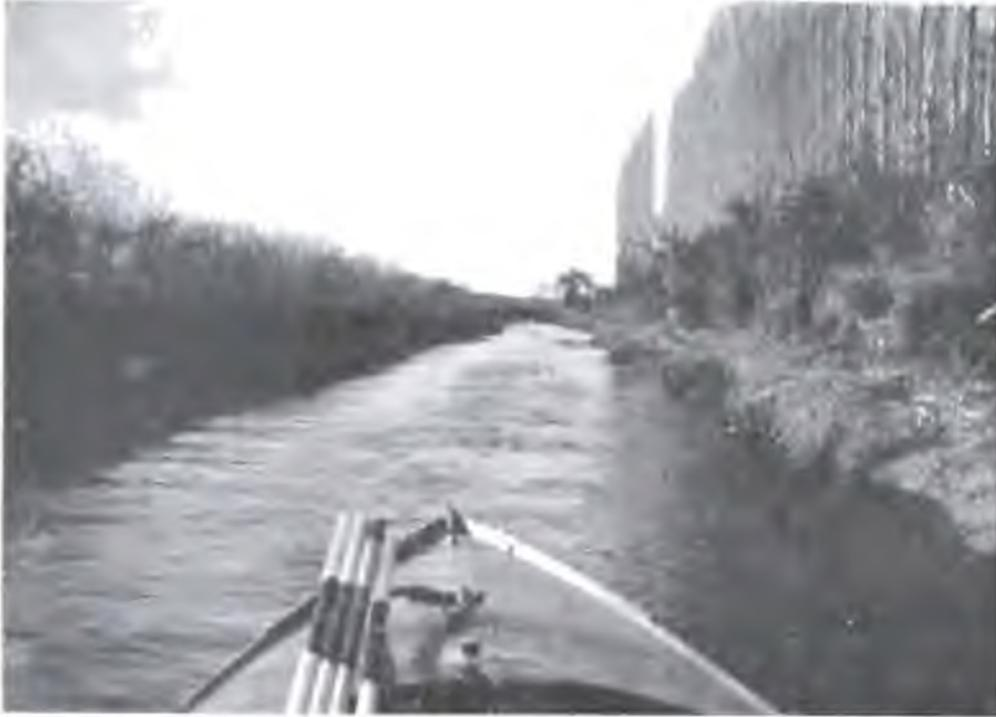
**Arroyo Romero (2<sup>a</sup> Sección).** — Tomada en la acumulada 1200 m. muestra el arroyo después de haber pasado la cuadrilla con trabajos de limpieza de las orillas y destronque.
