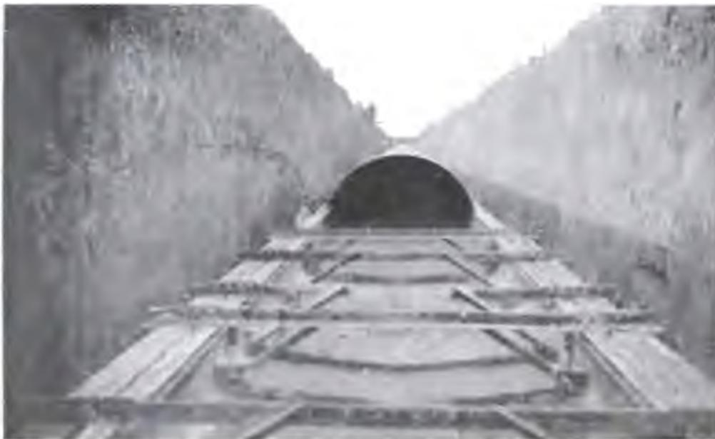
**Conducto de hormigón y bóveda de chapa Armco.**
