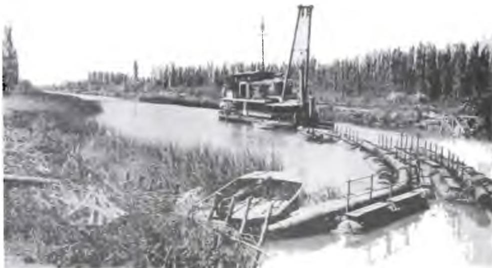
Esta foto muestra la draga 220 C del M. O. P. de la Nación realizando trabajos de dragado en el canal Gobernador de la Serna, en el tramo comprendido entre el arroyo Desengaño y arroyo Pay Carabí. Los trabajos auxiliares de la cuadrilla están a cargo del M. O. P. de la Provincia. (Estos trabajos iniciados al finalizar el año 1937, continúan en la actualidad).
