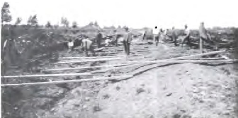
Limpieza del cauce del río Salado, preparando planchas de tablones en la cancha de la foto anterior, para empezar las excavaciones.
