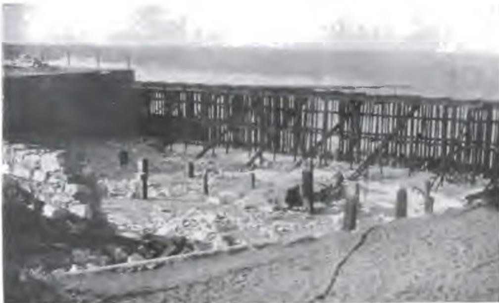
**Punta Iglesia (24 mayo 1937). — Contrafuertes del muro en construcción.**
