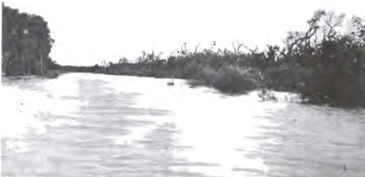
**Arroyo Manzano de la Barca (3ª Sección).— Esta vista fué tomada en el mes de diciembre de 1937, desde el río Barca Grande y muestra la entrada al Manzano de la Barca, después de ser profundizada y rectificada la boca.**
