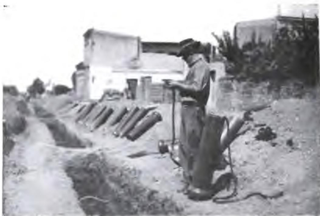
Vista de la zanja terminada, lista para ser colocada la cañería de material vítreo.
