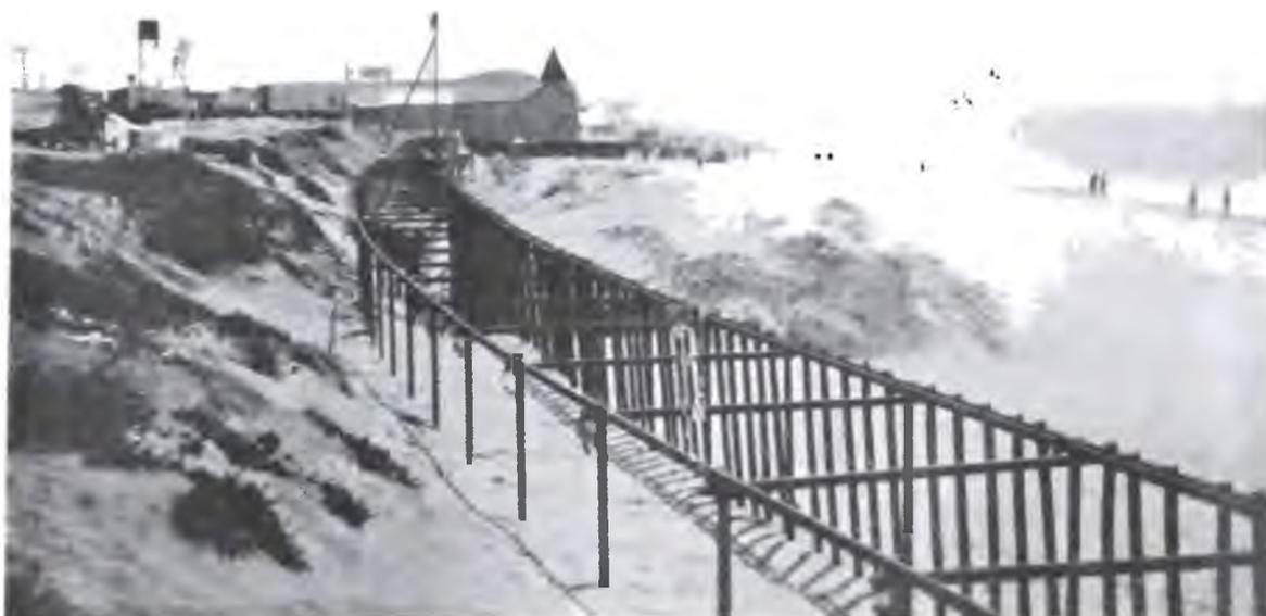
Miramar (31 diciembre 1937). — Rieles hincados para construcción del muro longitudinal a la costa.
