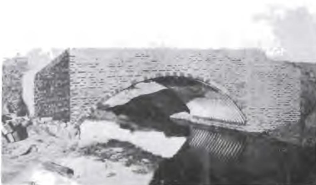
Puente sobre el arroyo Carnaval — 7 m. de luz construido con chapa acanalada Armco.
