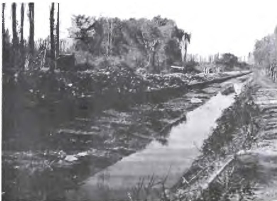
**Vista tomada en la acumulada 7100 m. mostrando parte del arroyo ya rectificada y profundizada con una punteada de tierra.**
