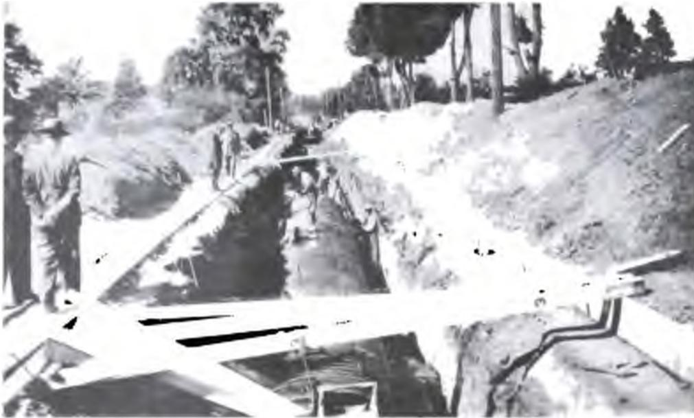
**Entubamiento del Zanjón Sarmiento. Iniciación del conducto.**
