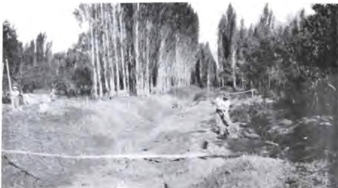
**Zanja Torres (2ª Sección). — Esta vista tomada en la acumulada 45, muestra los trabajos preparatorios hechos con cuadrilla, antes de iniciar el dragado.**
