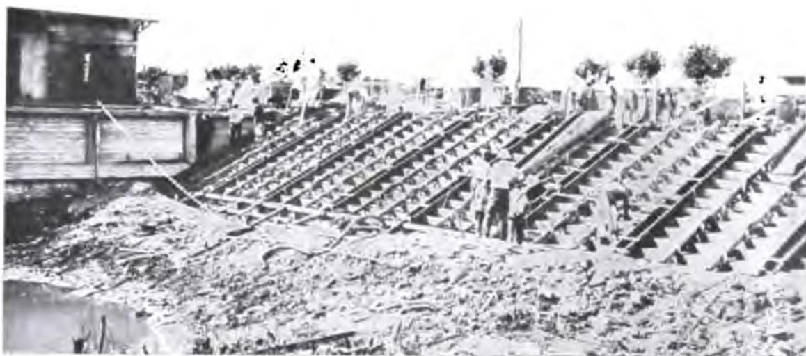
**Construcción del muro escalonado de la Dársena 2.**
