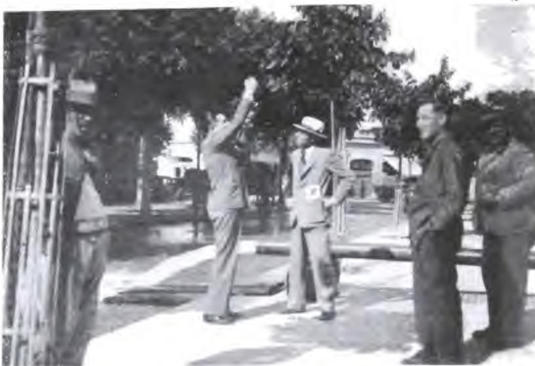
**En el pozo perforado en la Plaza Rocha, observando una muestra de agua recién extraída, para verificar la ausencia de arena.**
