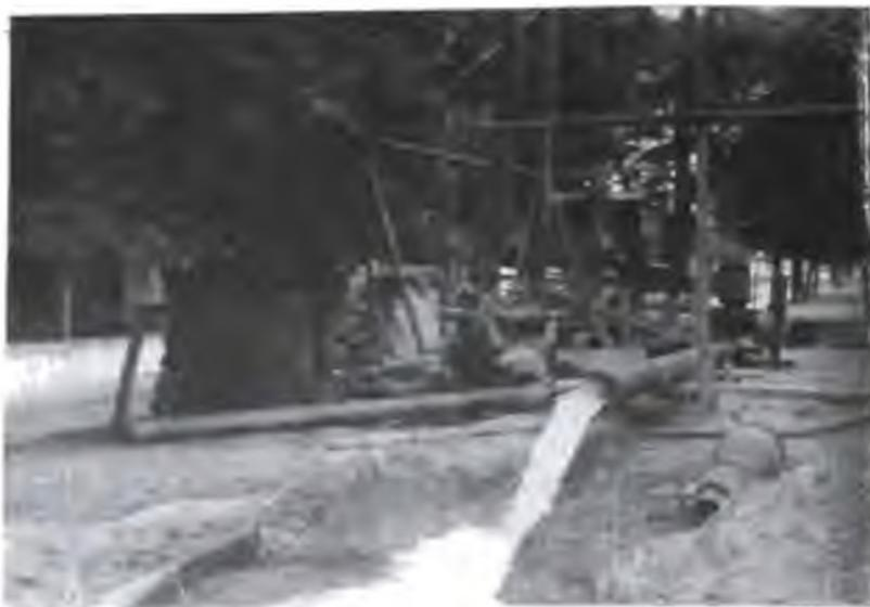
**Una vez terminada la perforación del pozo en la Plaza Passo, se efectúa el ensayo de rendimiento en volumen**
