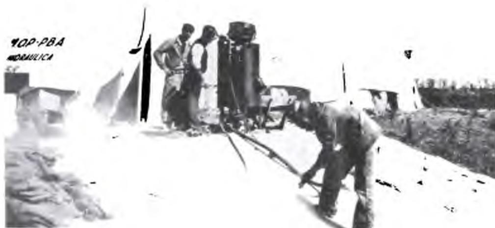
Canal N° 1. — Equipo de limpieza mediante proyección de arena.
