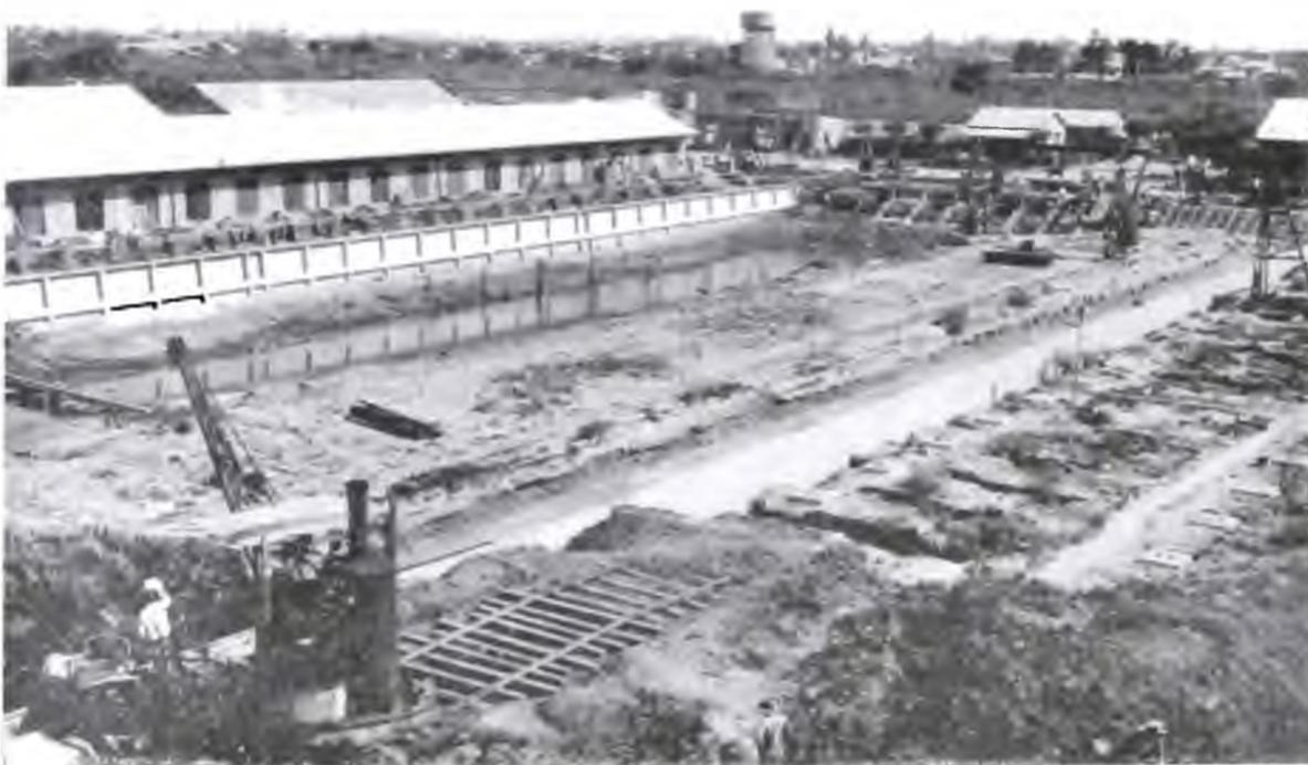
**Vista de la excavación y construcción de la Dársena 2.**
