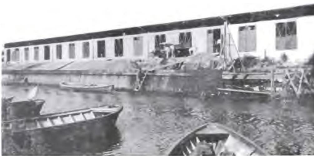
Dársena 2. — Construído el tablestacado de madera.
