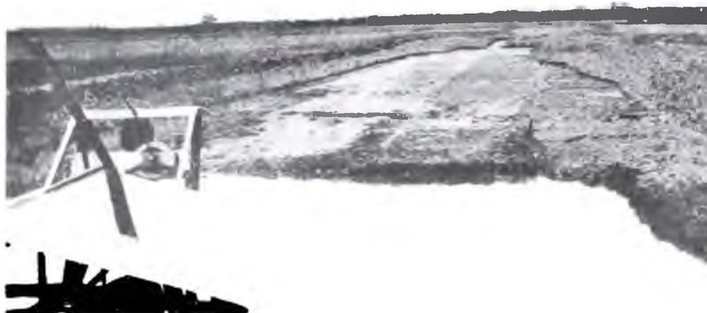
**Punta Morán (2ª Sección). — Trabajos preparatorios para el dragado efectuados con cuadrilla, al iniciar la desviación de Zanja Torres hacia Punta Morán, donde la draga 254 D está en la actualidad (enero 1938), efectuando la profundización de este futuro canal.**
