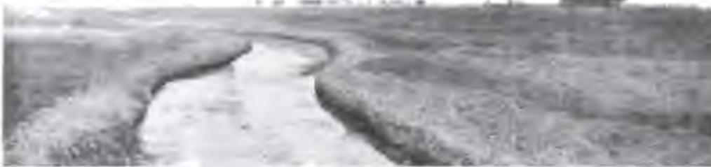
**Limpieza del cauce del río Salado. Vista del trozo del río Salado en la foto anterior después de ejecutado el trabajo de limpieza y profundización. Falta cortar los taludes.**
