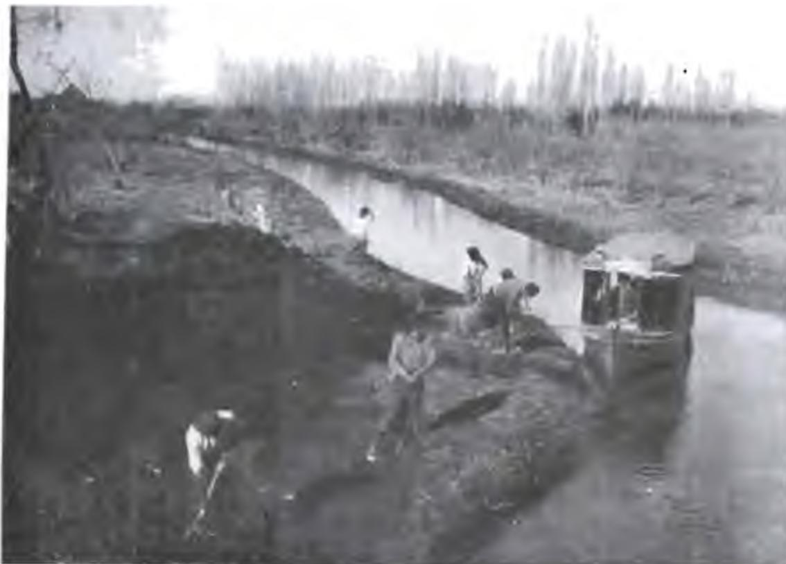
**Arroyo Las Cañas (2ª Sección).**— Esta vista muestra un tramo de arroyo frente a la desembocadura del arroyo Canelones. Véase el tramo rectificado y limpiado y en primer plano una pronunciada curva en la que se hacen trabajos de rectificación.
