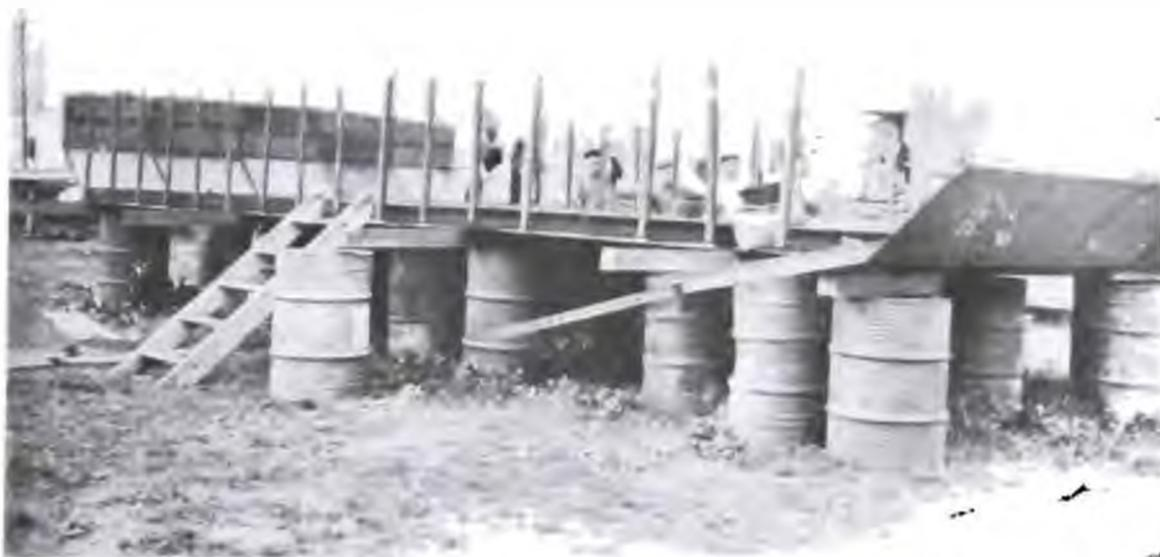
**Construcción de una balsa. — Con destino a la Municipalidad de San Pedro, en el taller y varadero del Delta se ha construido una balsa de hierro. Esta vista muestra la iniciación de los trabajos de construcción.**
