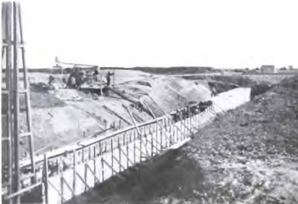
**Sifón Hm. 113,72 el Canal N° 5. — Vista de un tramo hormigonado y otro en obra del conducto de 160 metros de longitud.**
