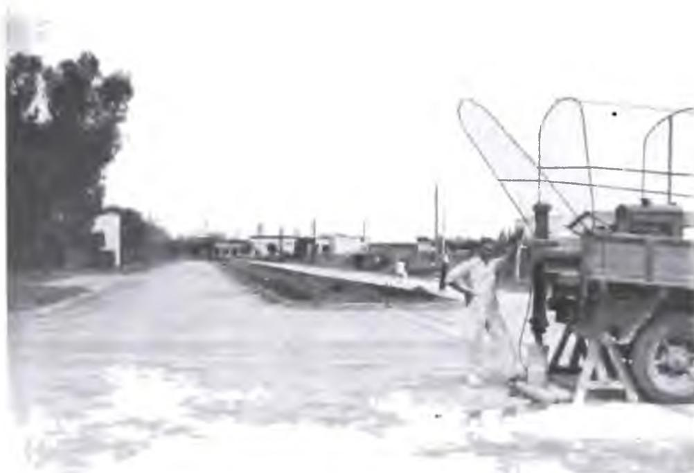
**SEIS DE SEPTIEMBRE.** Ituzaingó. Calle Int. Ratti. Pavimento Hormigón Armado. Extracción de probetas.
