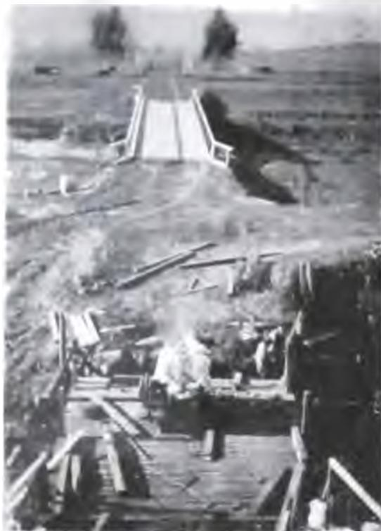
Puente principal de 27,50 m. de luz sobre el Canal N° 5 y puente auxiliar de 5,50 m. de luz sobre el Canal lateral Hm. 418.
