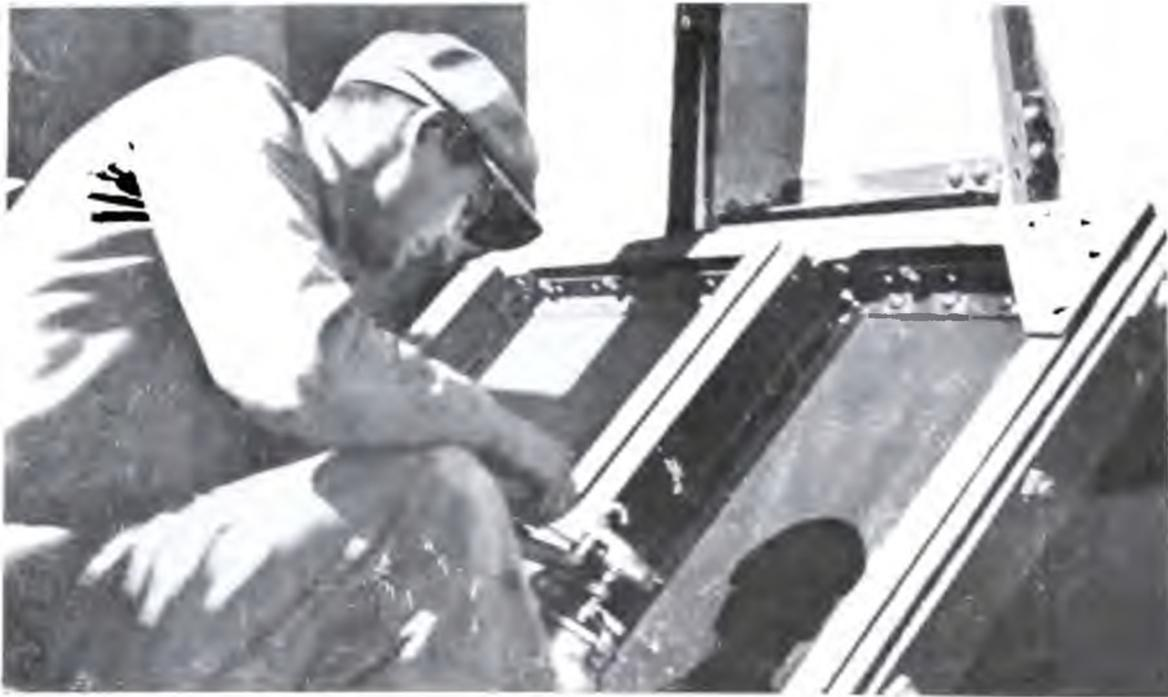
**Canal N° 1. — Trabajos de pintura de compuertas mediante la utilización de aire comprimido.**
