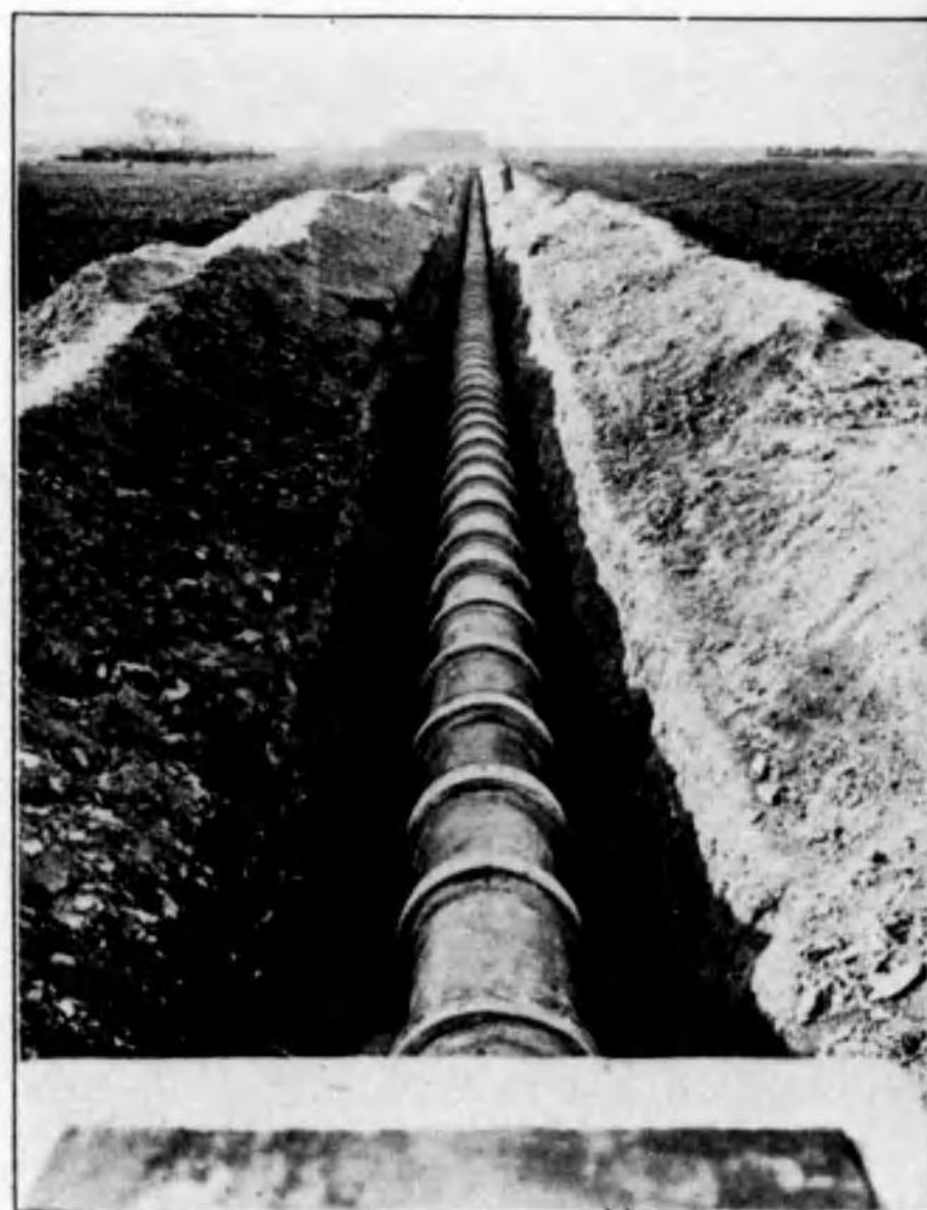
上 愛媛縣宇摩郡津根村耕地整理 組合ノ「サイホン」工事 右 岩手縣和賀郡和賀中央耕地整 理組合ノ尻平川掛樋
