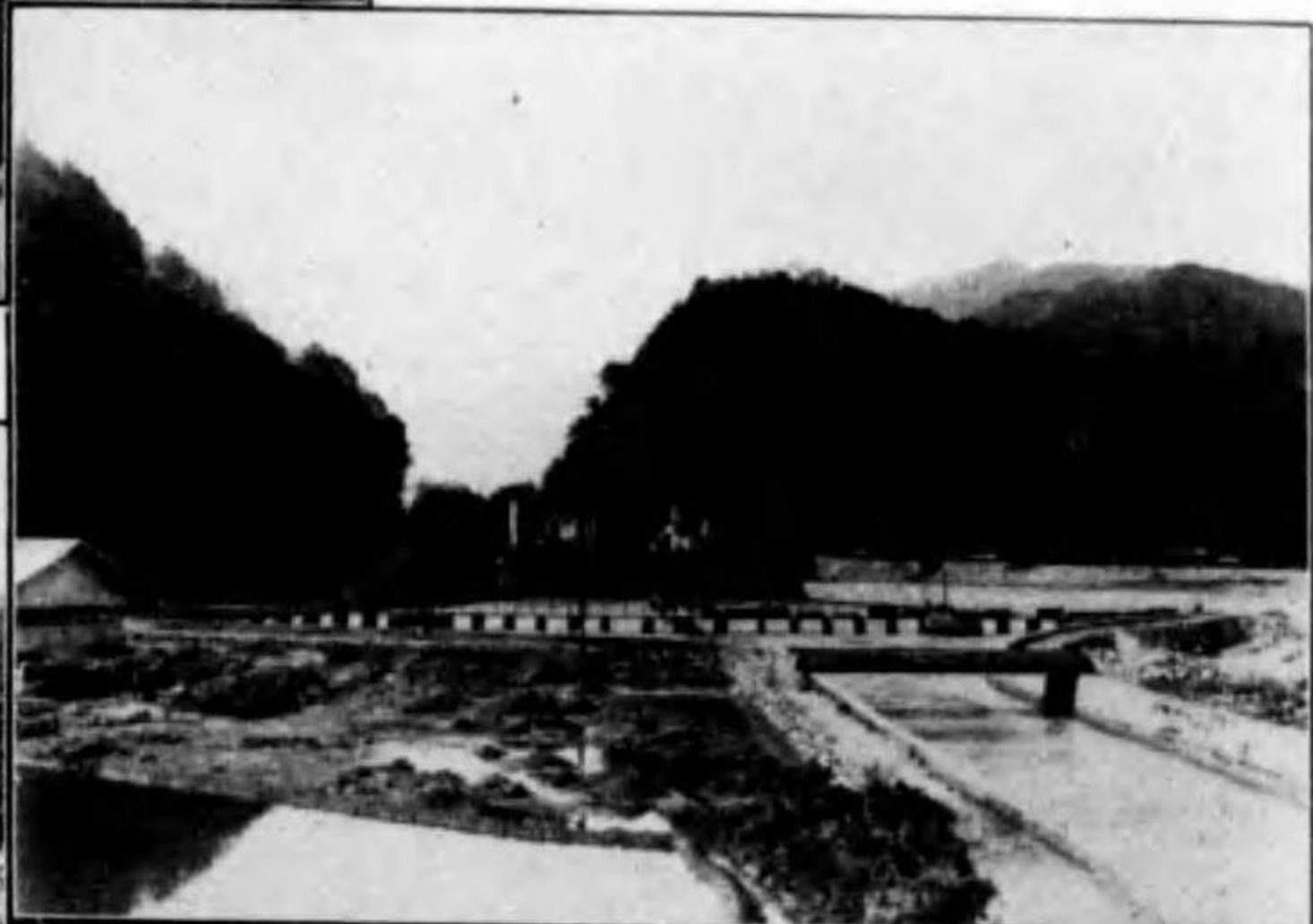
左 富山縣磐城川沿岸用水改良 事業堰堤 右上 同上事業ノ沈砂池 右中 岩手縣和賀郡和賀中央耕地 整理組合ノ用水管線ノ一部
