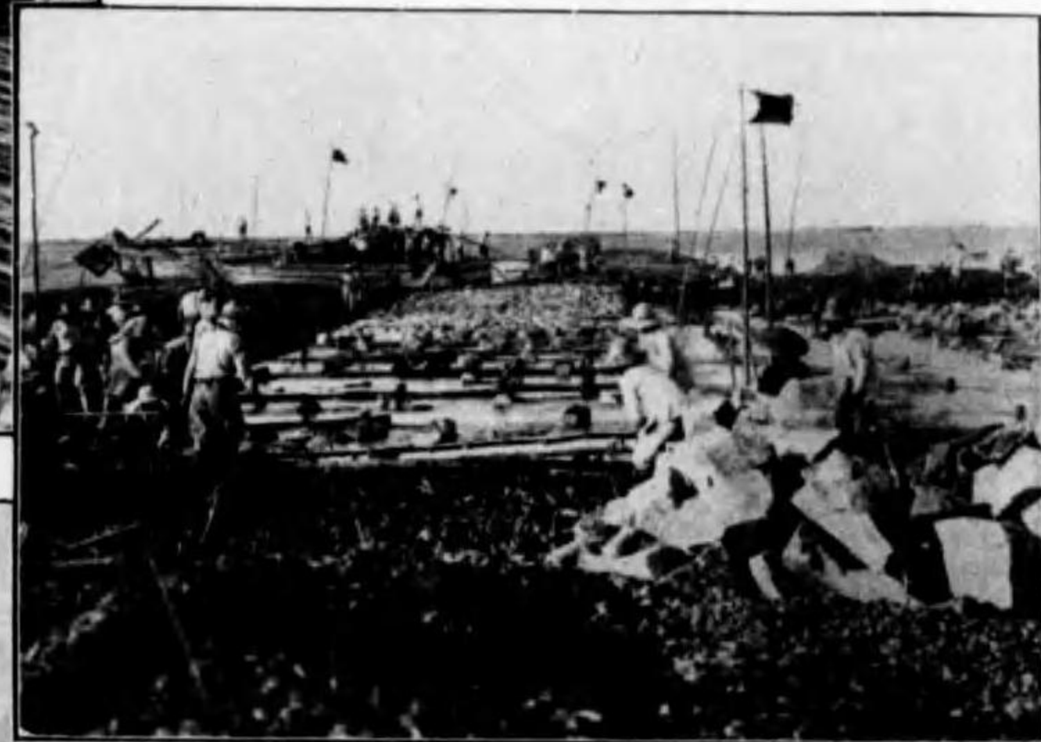
上 佐賀縣營干拓地ノ潮止口逆石張狀 左 福島縣相馬郡八澤村八澤浦干拓地ノ排水機及自動水門工事
