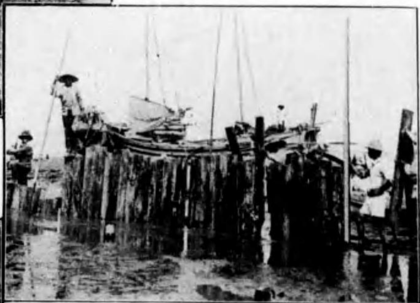
左 山口縣厚狹郡藤山村干拓事業 (耕地整理共同施行)ノ堤防ノ一部 下 佐賀縣杵島郡南北有明村地先 佐賀縣營干拓地基礎工事(漏水止矢板立込)
