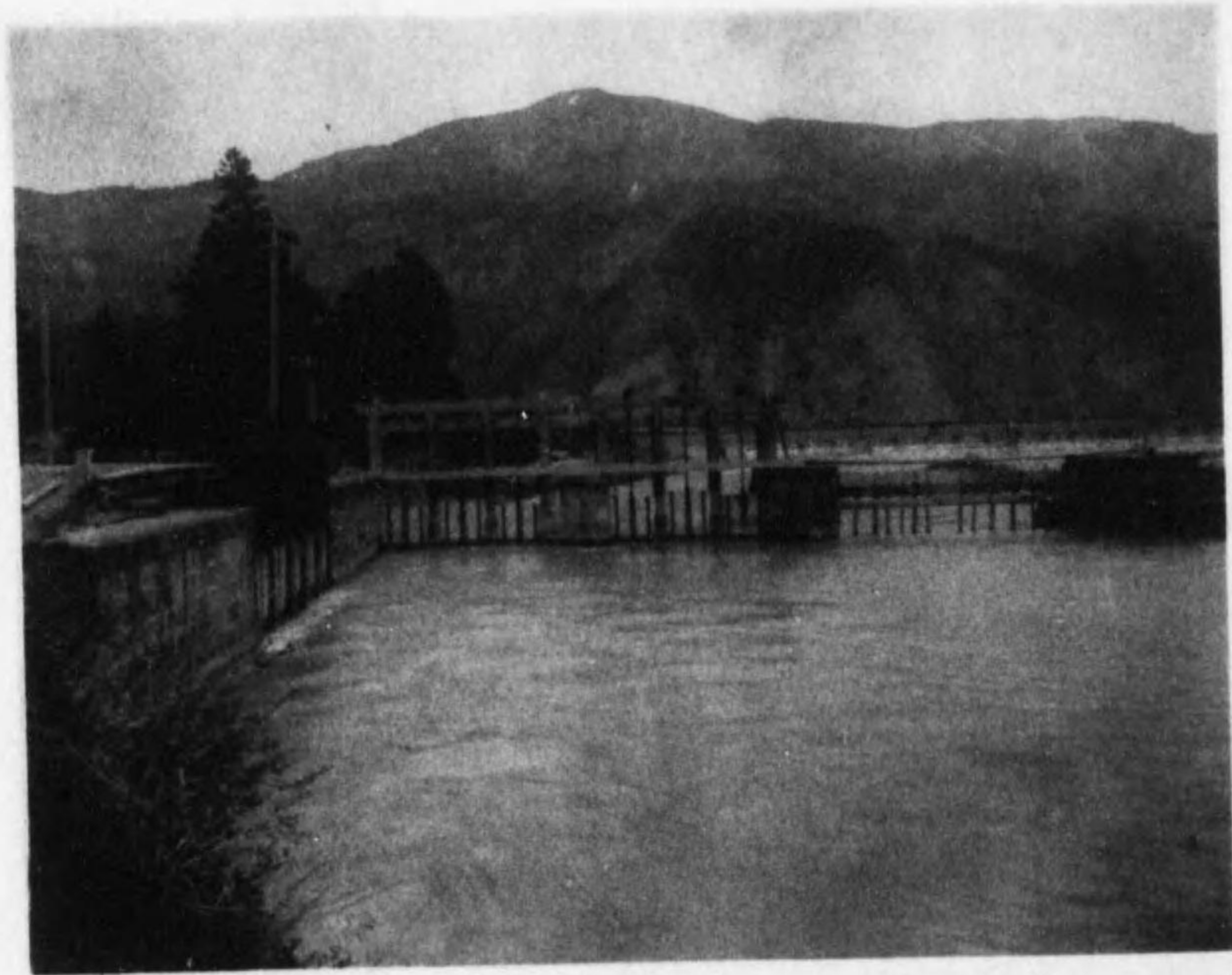
北橋堰取入口
