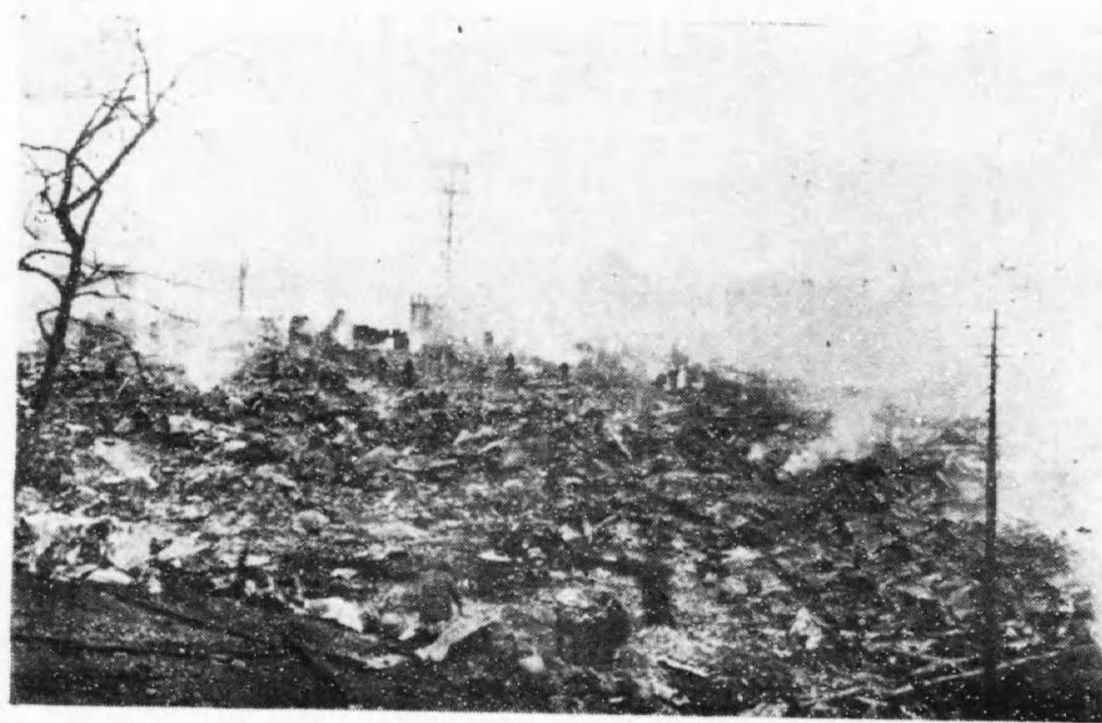
(況狀害被面方越只所場町石釜)
