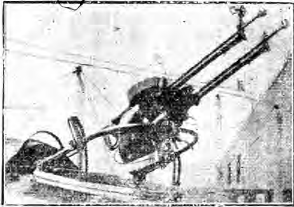
環置安與部上體胴機飛於置安槍機 圖三第
