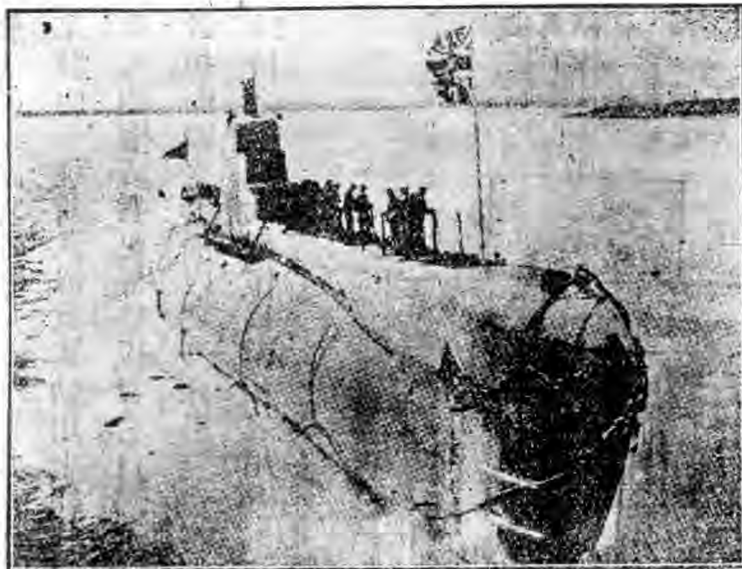
排 水 量 在 水 上 為 五 千 七 百 噸 在 水 中 為 二 千 四 百 噸 裝 備 有 魚 雷 發 射 管 八 門 四 吋 一 門 水 上 門 一 門 速 力 為 七 十 哩 半
