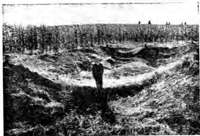
第一百六十六圖 懸網式節制壩築成一年後之情況。
