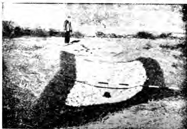
第一百四十二圖 階田排水渠之作法與第一百四十一圖者同，惟加鋪草皮。
