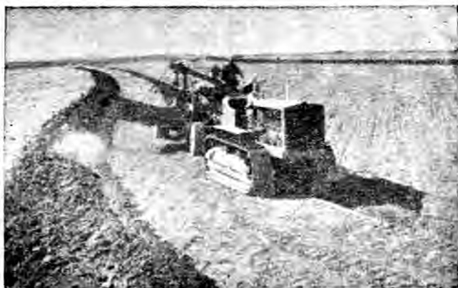
第一百八圖 重式高舉整平機，以五十馬力曳引機拖之，築路埂核心之情況。
