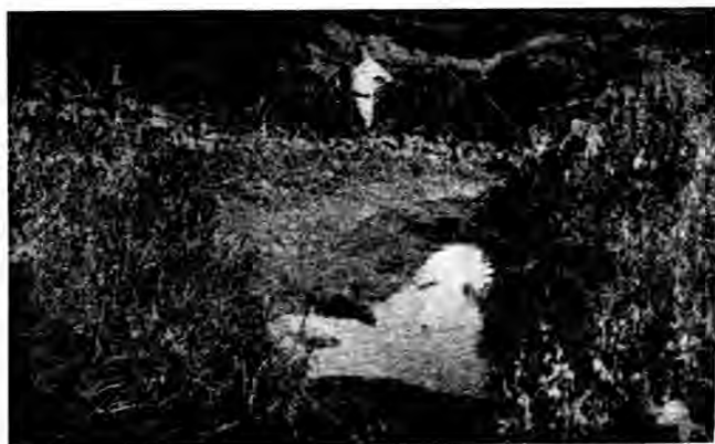
第一百五十九圖 雙排椿橫梢式壩經一次暴雨後之填淤。
