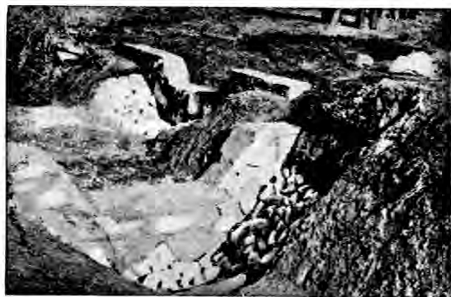
第一百四十三圖 階田排水渠與道路排水渠交會處之石壩。上壩保護階田，下壩保護渠道。
