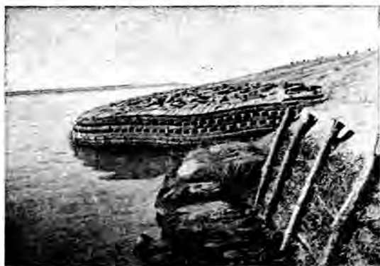
第二百二十六圖 黄河塌塌護岸。
