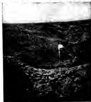
第一百七十三圖 溝槽中一組乾砌石壩。
