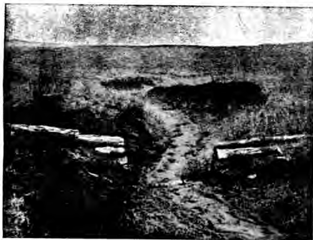
第一百七十六圖 樹木壩一年後淤填之情況。圖為向下游眺望之景。
