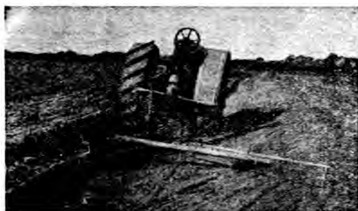
第九十七圖 曳引機拖V式鋼拖板修築階田之圖。
