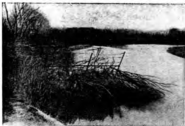
第二百十七圖 小河中之鋼製透水壩。
