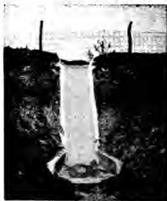
第一百五十四圖 混凝土引槽。
