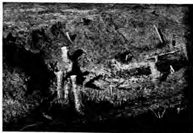
第一百七十一圖 與第一百六十九圖所示者爲同一壩。因前者未能隔離畜類，故植物因之斷絕。
