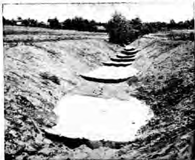
第一百五十一圖 一組鐵絲節制壩之圖，表示其距離及高度之設計。缺口面積，似屬不當。溝之兩岸，已整理妥當準備種草之用。
