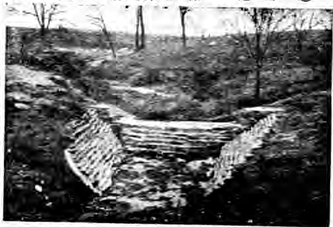
第一百八十一圖 石壩建築於兩溝槽相會處之下游之情況。
