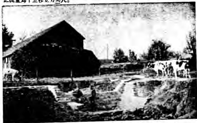
第一百五十六圖 明尼蘇達州利用乾砌石壩以防護懸崖。
