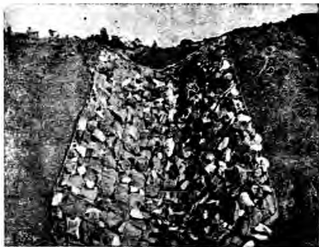
第一百四十一圖 以鐵絲網罩碎石築成之稻田排水渠口，網空約一英尺。
