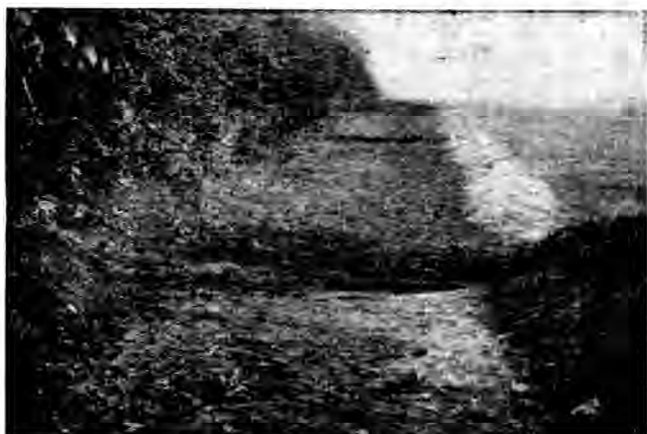
第一百三十七圖 分佈板並輔以草皮保護渠道之情況。
