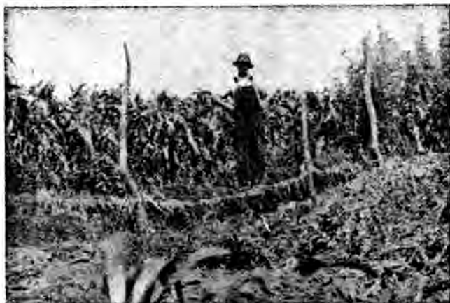
第一百六十七圖 懸網式節制壩已將溝淤滿，並種植玉蜀黍之情況。
