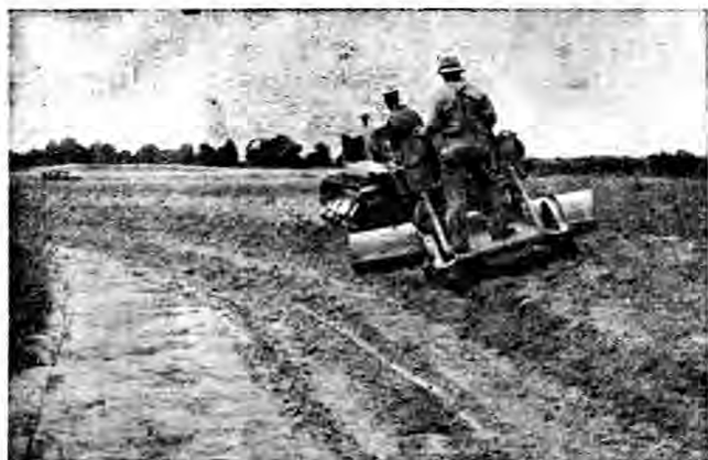
第一百五圖 兩輪，一四〇〇磅，八英尺葉片整平機，以二十二馬力曳引機拖之，於乾硬之黃黏土上築階情況。
