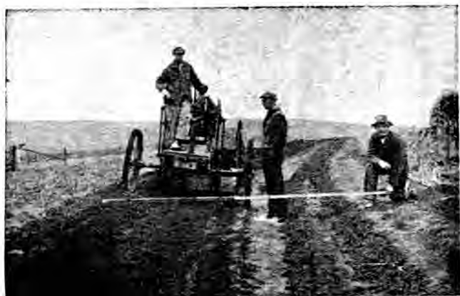
第一百三圖 四輪修路整平機，以農用曳引機拖之，自上坡築階情況。
