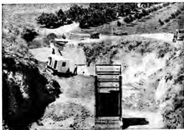
第二百二圖 正處築中之高壩，涵洞進口裝有增高水面之設備。
