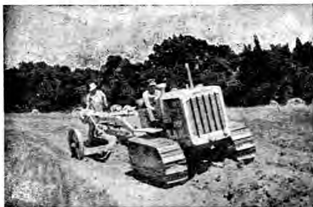
第一百六圖 兩輪，四五〇〇磅，十英尺葉片整平機以四十馬力曳引機拖之，築階情況。
