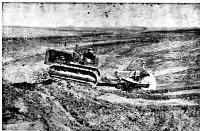
第一百十九圖 傅林納旋轉式刮板，拖以曳引機在石砌地鋪處情形。
