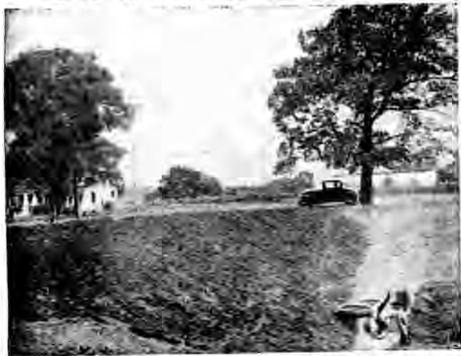
第一百九十三圖 保護土壩安有管狀涵洞之圖。
