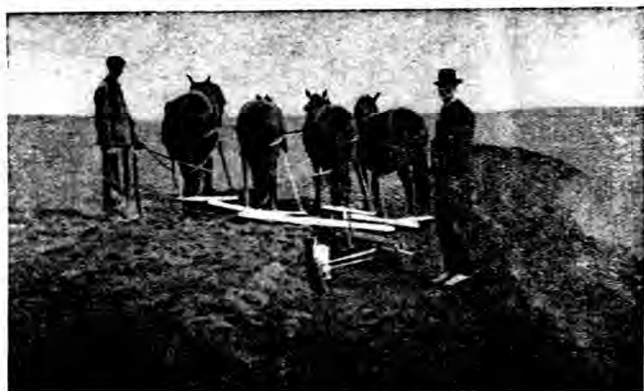
第九十六圖 四馬駕V式鋼拖板修築階田之圖。
