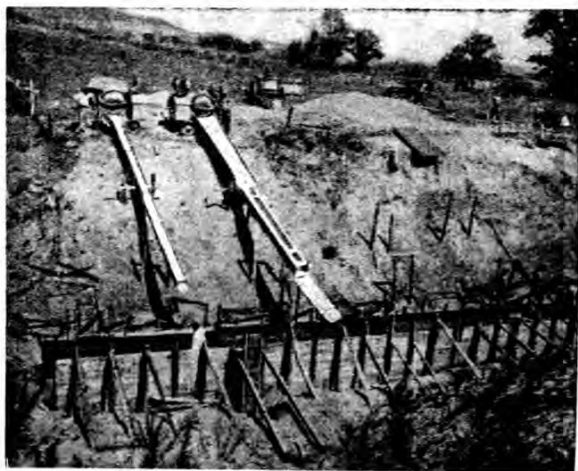
第一百九十七圖 方形混凝土涵洞之木模及澆灌時情況
