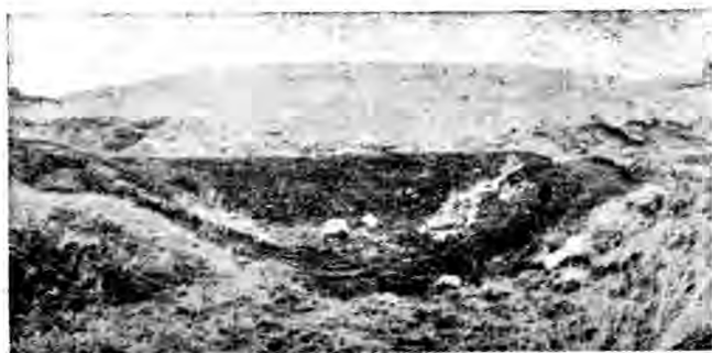
第一百八十九圖 土壤之兩旁有溢水道，此圖為向上游眺望之景。其後溢水道即用混凝土鋪之。水自雙方同時下流，互相撞擊以消滅水力。
