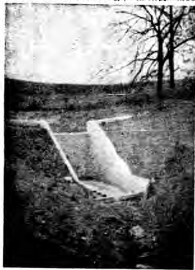
第一百八十五圖 鋼筋混凝土缺口壩甲式修築後之情況。
