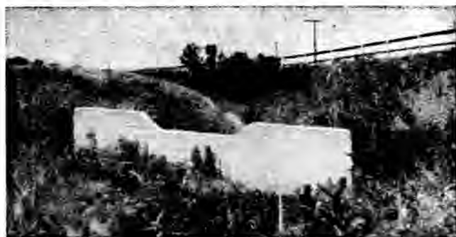
第一百四十七圖 節制壩之缺口容量不足，兩岸被冲刷之情況。
