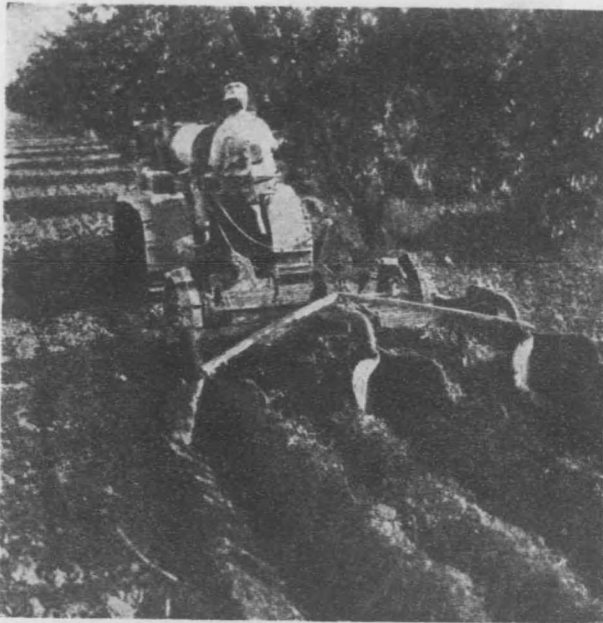
圖 246 加利福尼亞果園中,用以開掘溝渠之履帶牽引車,此種“穿田越野之車頭”(cross-country locomotive),亦用之於築路與伐木。
