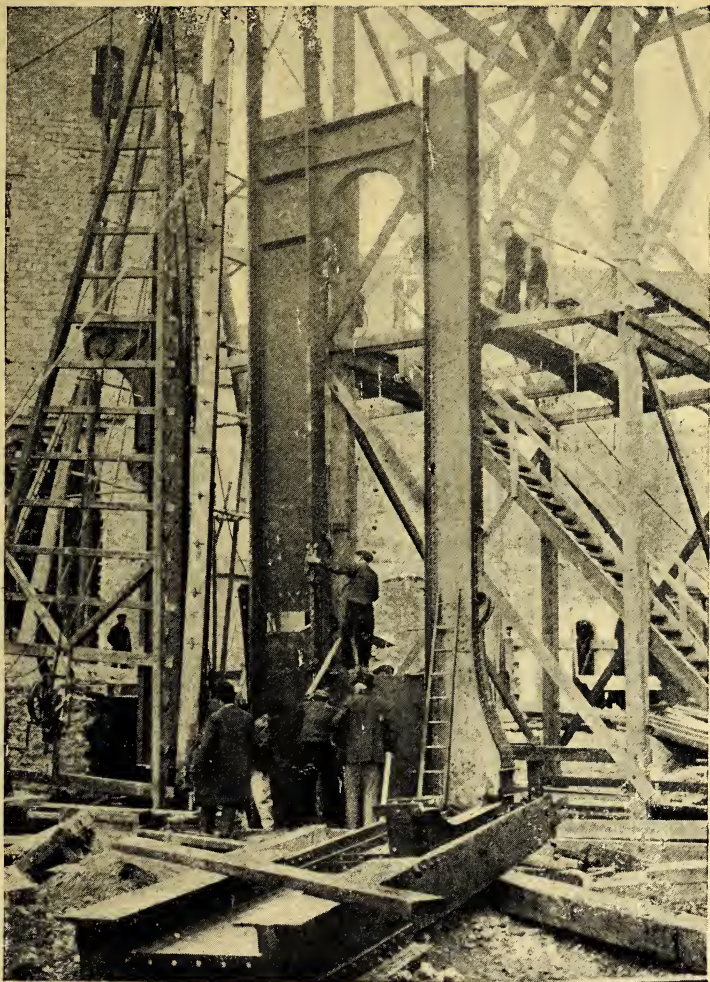
GRAND PALAIS. — MONTAGE DES FERS POUR LA COUVERTURE . (18 juin 1899.)
