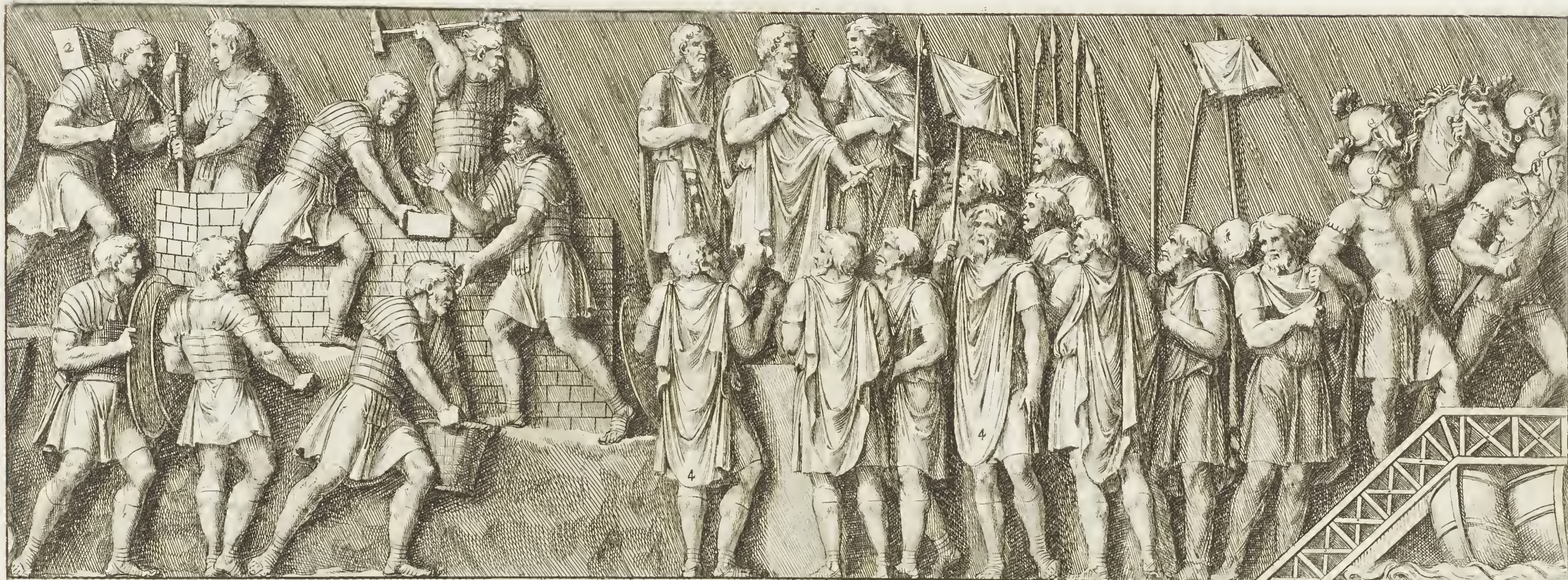
1. Milites, ex Romane militie disciplina, atque exercitatione, castra locant, ac aedificant 2. Saxum dolatum et quadratum, fune adligatum super humeros, facilius oneri ferendo, ad munificer suos miles deducit
