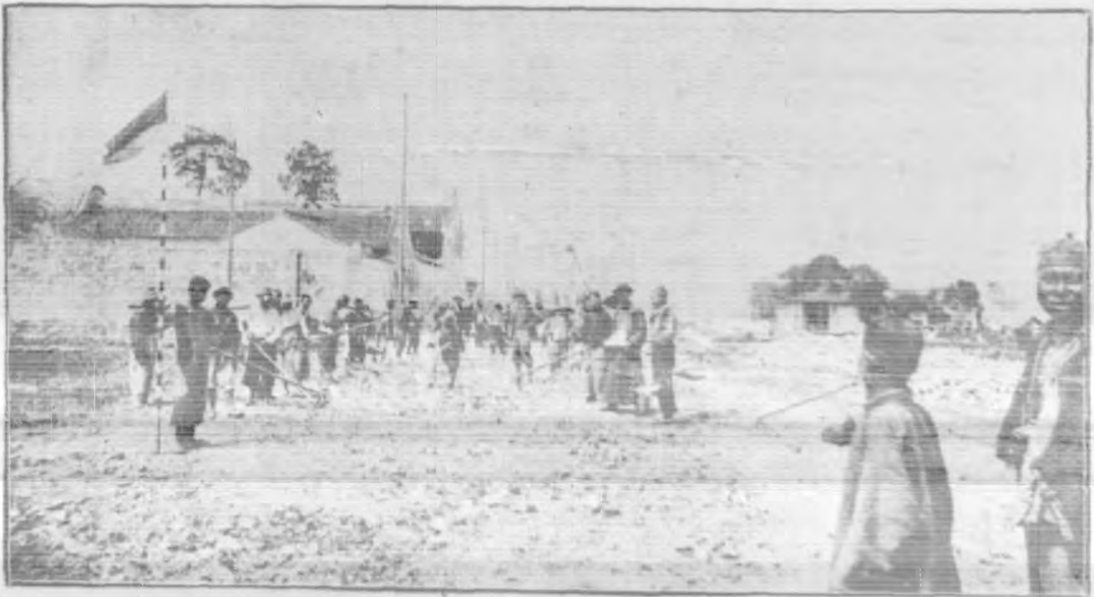
公園道寶善橋北段築路情形
