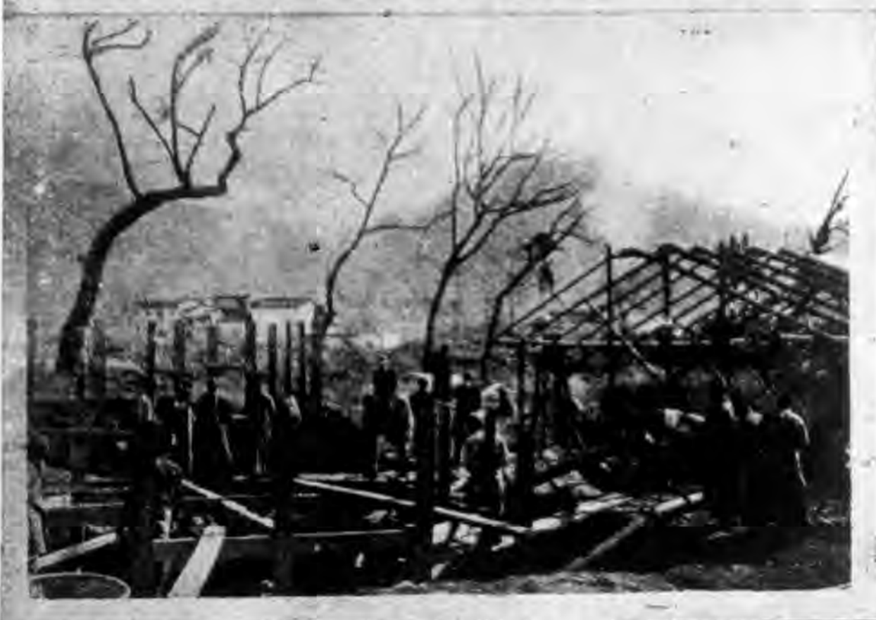
→ 績溪南門大橋工程進行 狀況
