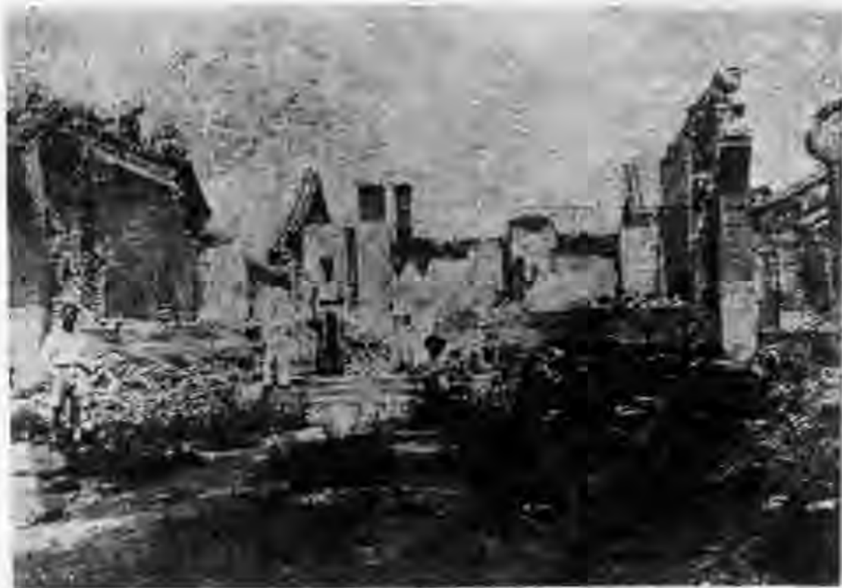
溫泉療養院破壞狀況
