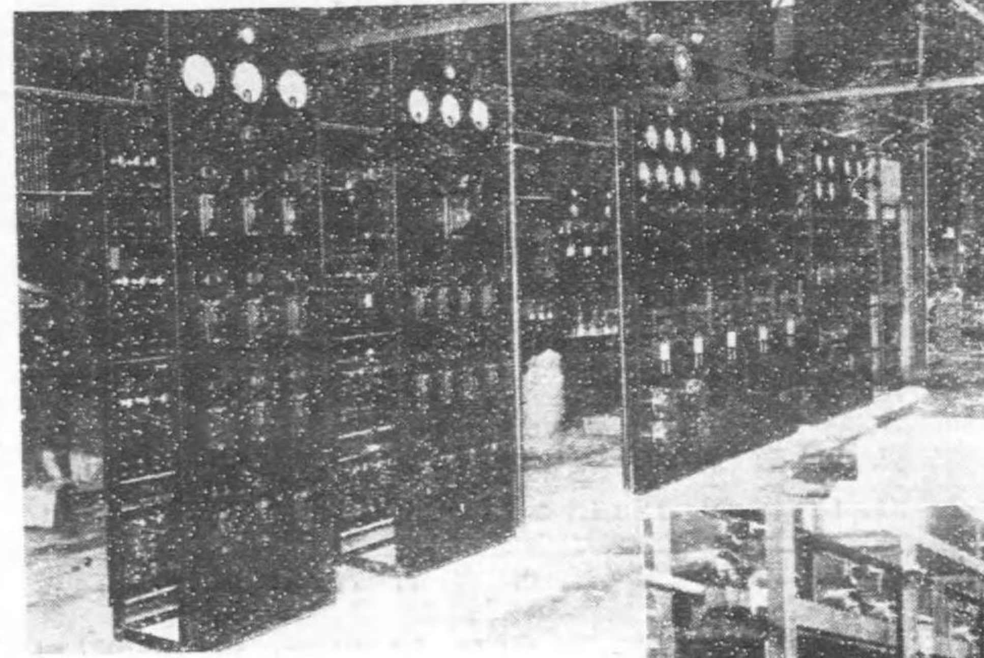
K. S. デッドフロント型配電盤
