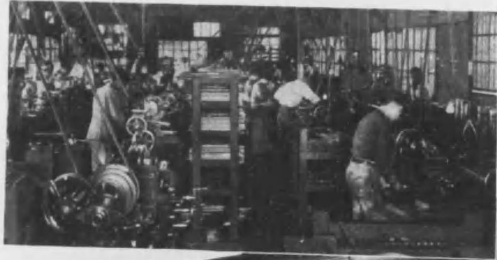
筋ローラー製作工場ノ一部
