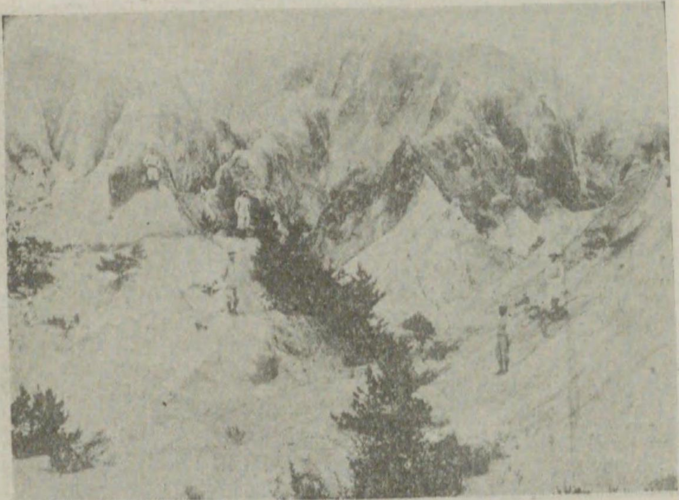
(洞ノ山堂保伊字大村見保郡茂加西) 前行施事工防砂
