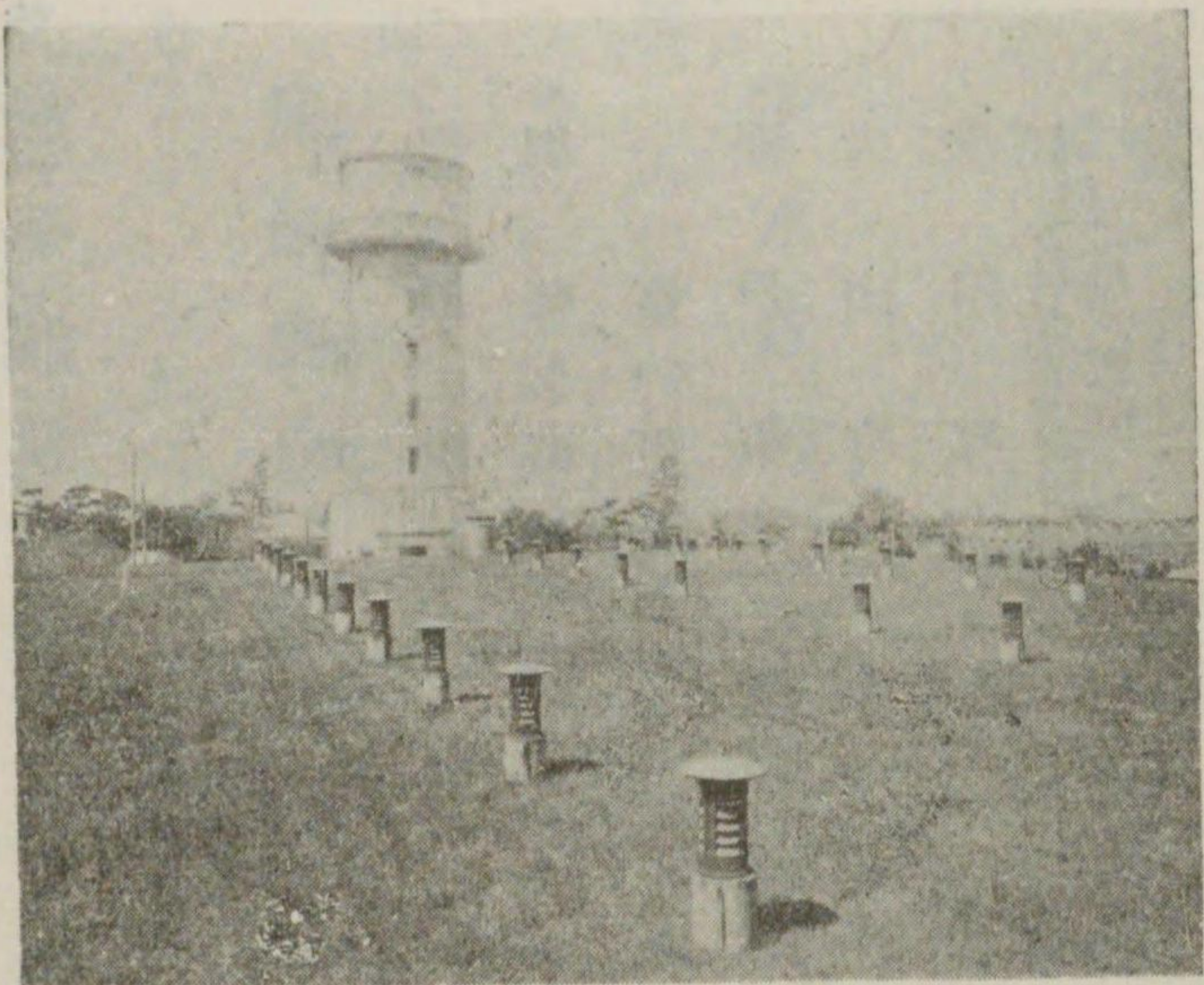
名古屋上市水道配水塔
