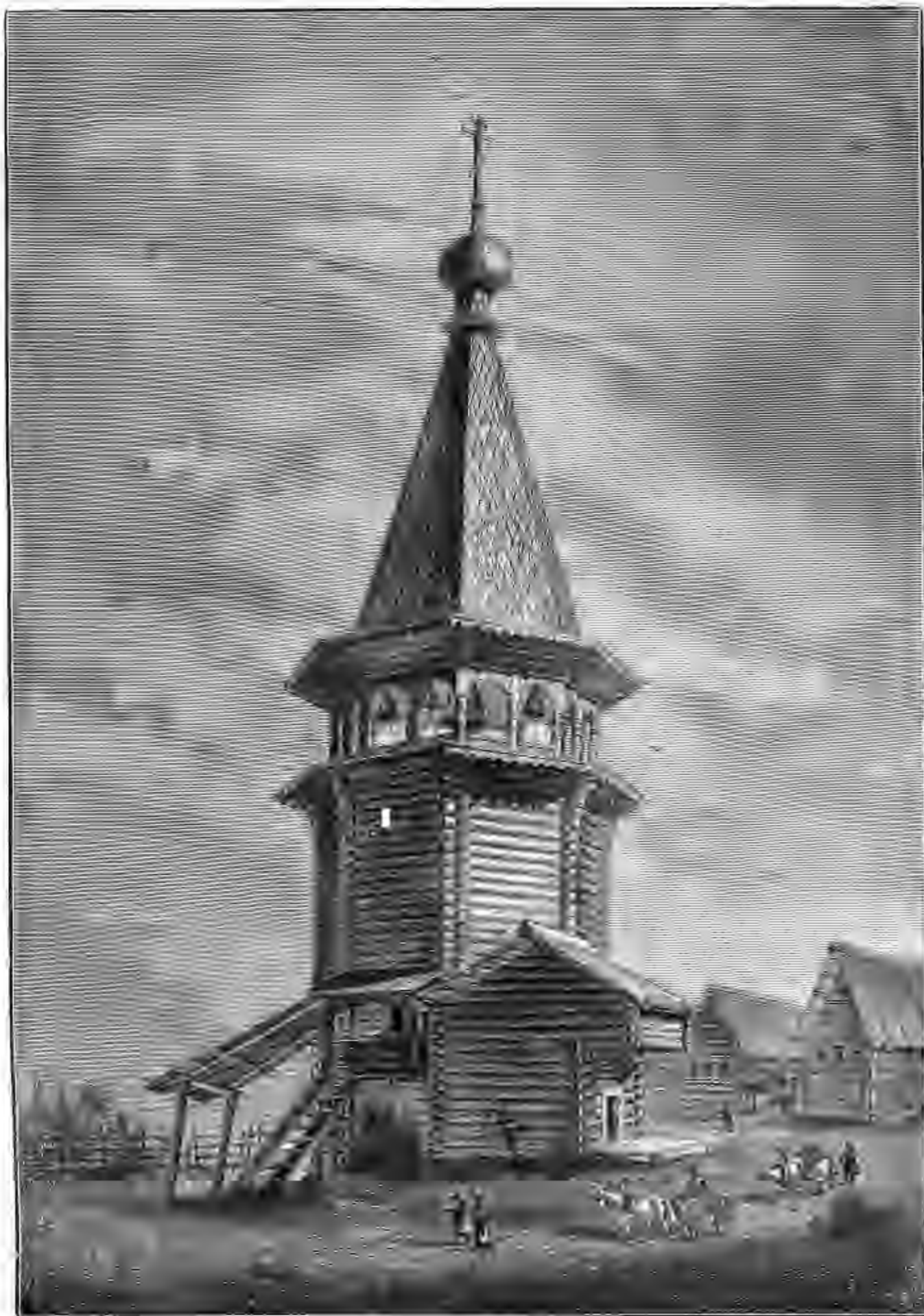
Деревянная колокольня на Нижне-Уфтыгскомъ погостѣ (Волг. губ., Сольвычег. уѣзда). Изъ альбома путеш. по сѣверу. Ориг. рис. съ натуры В. Сулова, грав. М. Рашевскій.
