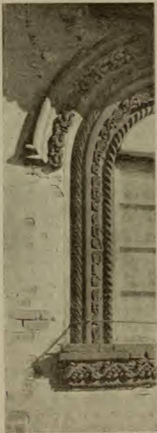
Fig. 28. — Carignano (Piemonte). Finestra ornata, terracotta nel monte di pietà: particolare. (Fot. Alinari, Firenze).
