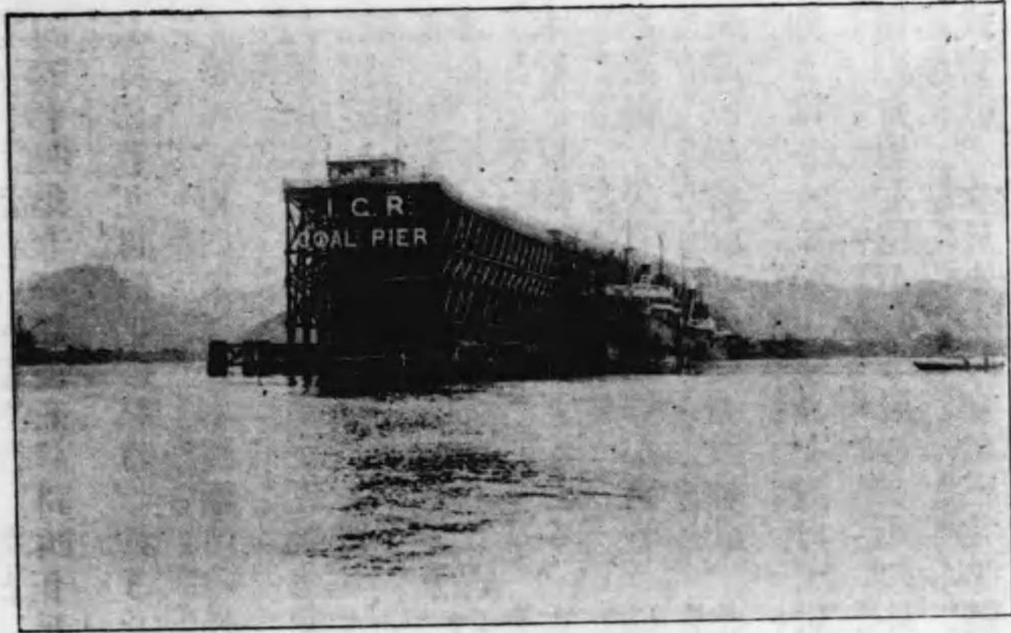
室蘭の高架橋
