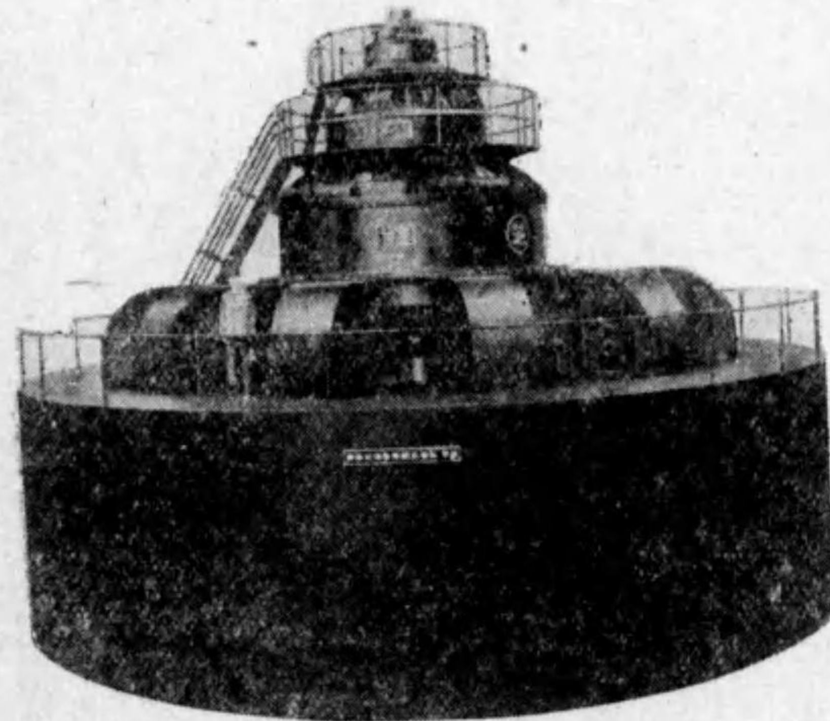
第 45 圖 水車發電機
